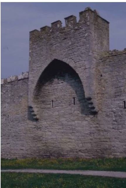
Fig. 5 - Wisby, Isola di Gotland (Svezia): torricella pensile rompitratta delle mura urbane del XIII secolo.
