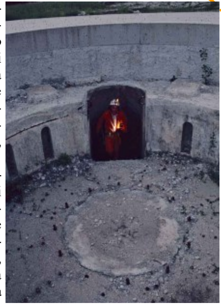
Fig. 10 - Colle di Osoppo (Udine): una delle installazioni a pozzo parzialmente restaurata, facente parte della Batteria Sud, originariamente armata con quattro cannoni da 149 mm sotto blinda girevole del tipo Grillo (foto pubblicata nell’Atlante Iconografico).
