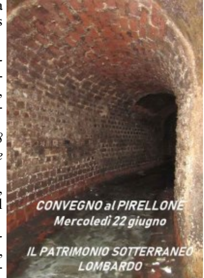
Uno scorcio della Milano Sotterranea.
