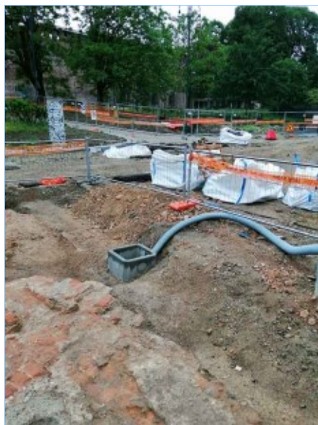
Fig. 143 - 28 luglio: esemplificativa immagine del cantiere.
