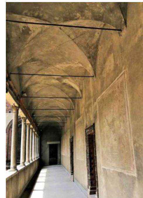
Fig. 58 - Chiusa al pubblico da decenni, la Ponticella oggi versa in precarie condizioni: vistose crepe negli intradossi delle arcate sono state semplicemente sigillate qualche anno fa con cemento (?) scuro, il tetto è da rifare e gli intonaci da soli testimoniano l'incuria e l'abbandono.
