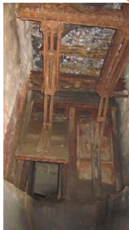
Fig. 19 - Resti di saracinesche per la regolazione dell'acqua nei canali sotterranei.
