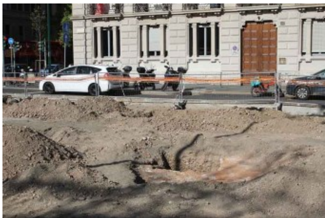
Fig. 101 - Siamo alle solite! 11 aprile 2022: in primo piano una delle fosse per piantare l'albero. Con la benna si è messa a nudo e intaccata una porzione del Baluardo Albuquerque facente parte della Fortezza Reale. In alto a sinistra si può riconoscere l'imbocco di Via Giovanni Lanza, ovvero dove nel 2013 già si era intercettato con le ruspe il baluardo rinascimentale. Pensavano che dopo una decina d'anni si fosse dissolto come per magia?
