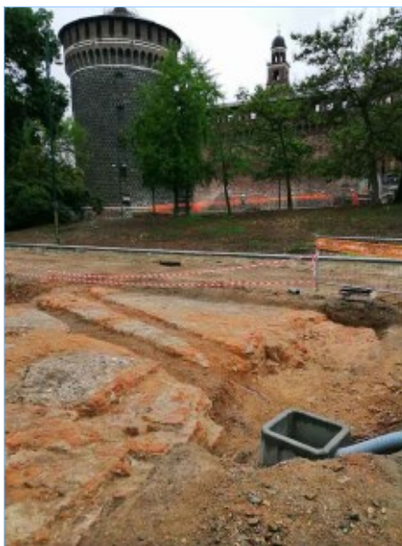
Fig. 144 - 28 luglio: emblematica immagine del cantiere.
