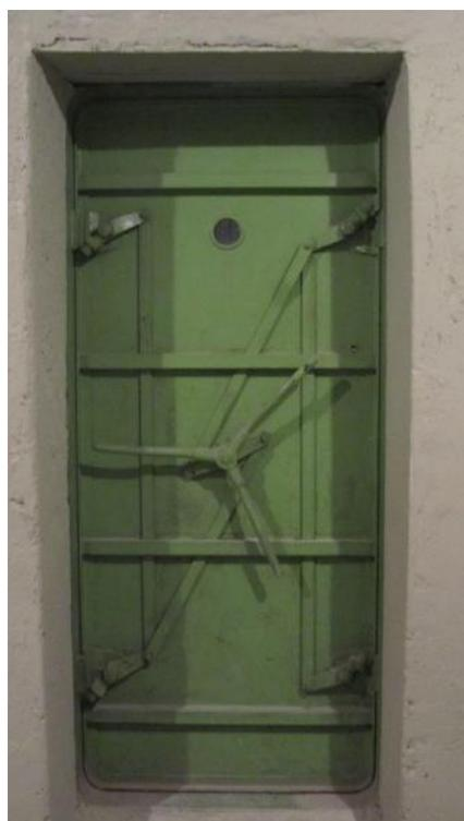
Fig. 6.144 - Una delle porte a tenuta stagna della Ditta Bergomi ancora visibile nel rifugio antiaereo della Croce Rossa di Como.
