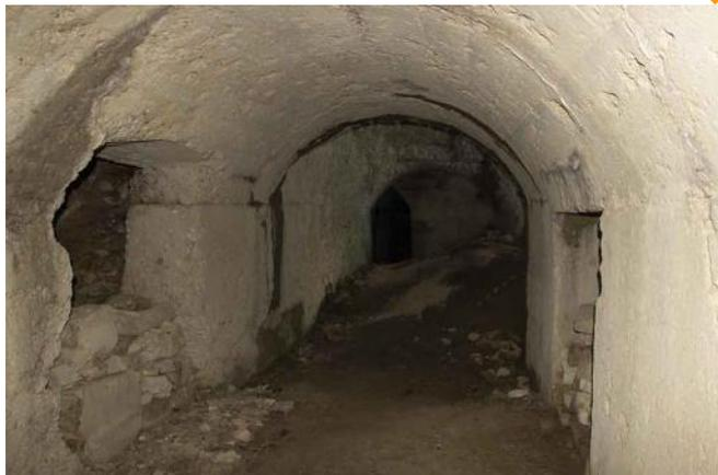
Fig. 6.127 - Guerra 1915-18. "Galleria cannoniera del Monte Fortin", la cui struttura interna era rivestita in calcestruzzo. Lateralmente si aprono le gallerie secondarie che in alcuni casi non sono completamente rinforzate e lasciano intravedere la retrostante roccia flyschoida, assai degradata e in alcuni punti collassata (Archivio M. Tavagnutti).
