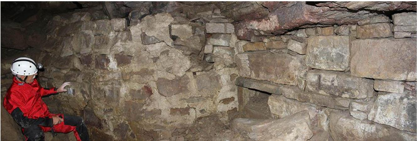
Fig. 6.105 - Monte Calvario (Gorizia). Il muro ritrovato all'interno della galleria è costituito da pietre squadrate unite da malta, in corsi non sempre regolari. Questo fa pensare ad una costruzione antecedente la Prima Guerra Mondiale e probabilmente legata alla presenza della vicina chiesa medievale (Archivio M. Tavagnutti).
