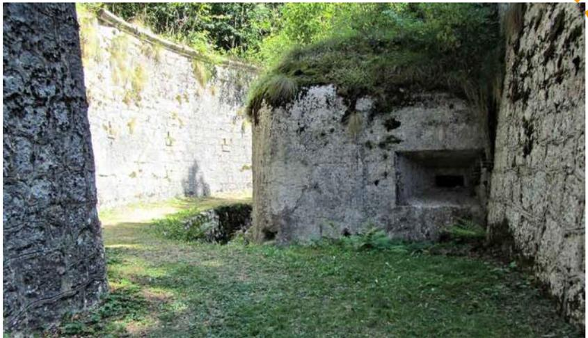
**Fig. 6.50 - Altopiano di Asiago, batteria corazzata italiana denominata Forte di Punta Corbin: primo piano della caponiera che tiene sotto controllo il fossato “tagliato” nella roccia e rivestito.**
