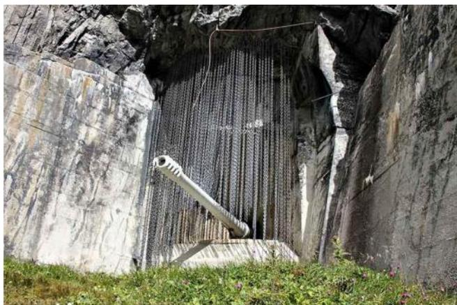
Fig. 6.129 - Forte San Gottardo (Svizzera): veduta esterna della feritoia della casamatta in cemento armato in cui è alloggiato il cannone da 150 mm.
