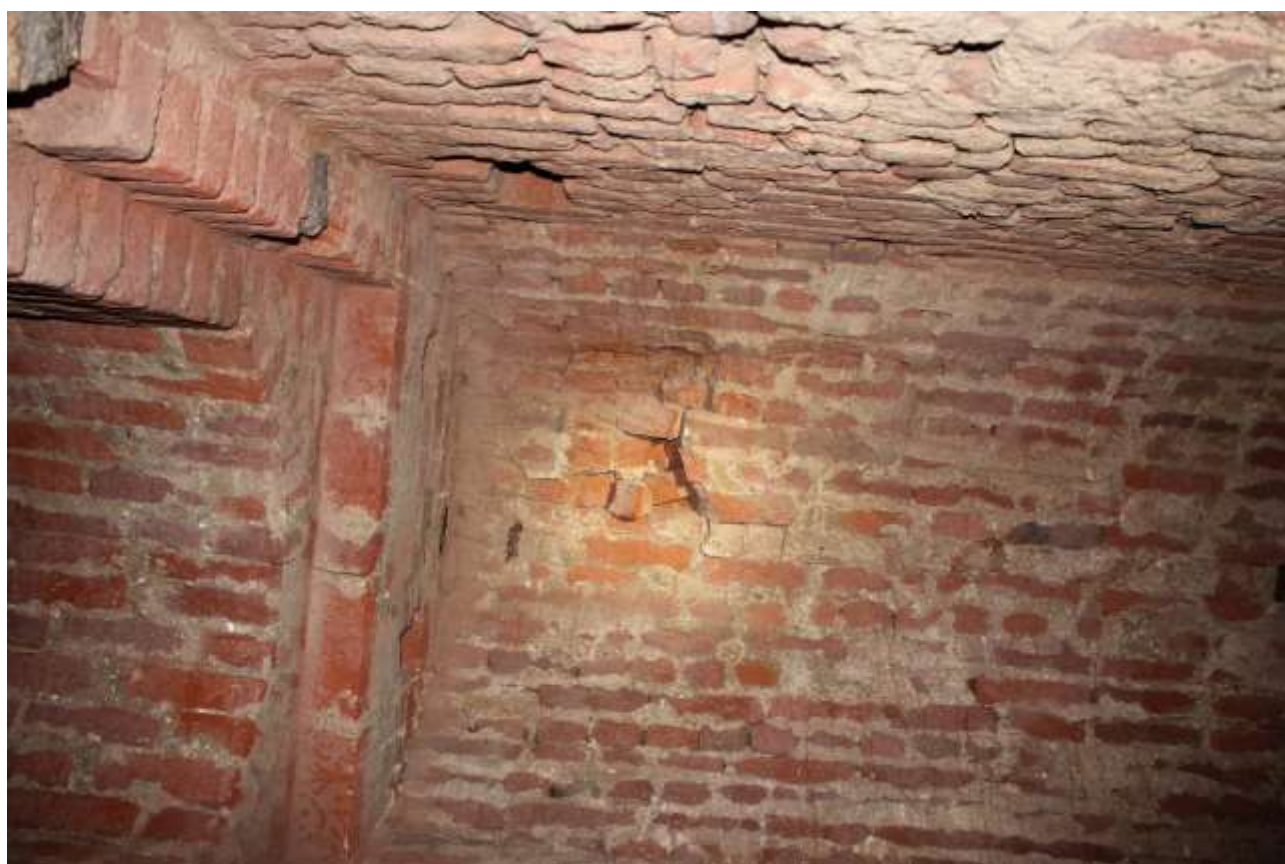
Danni causati alle volte quattrocentesche dal peso della ruspa e dall'azione della benna.
