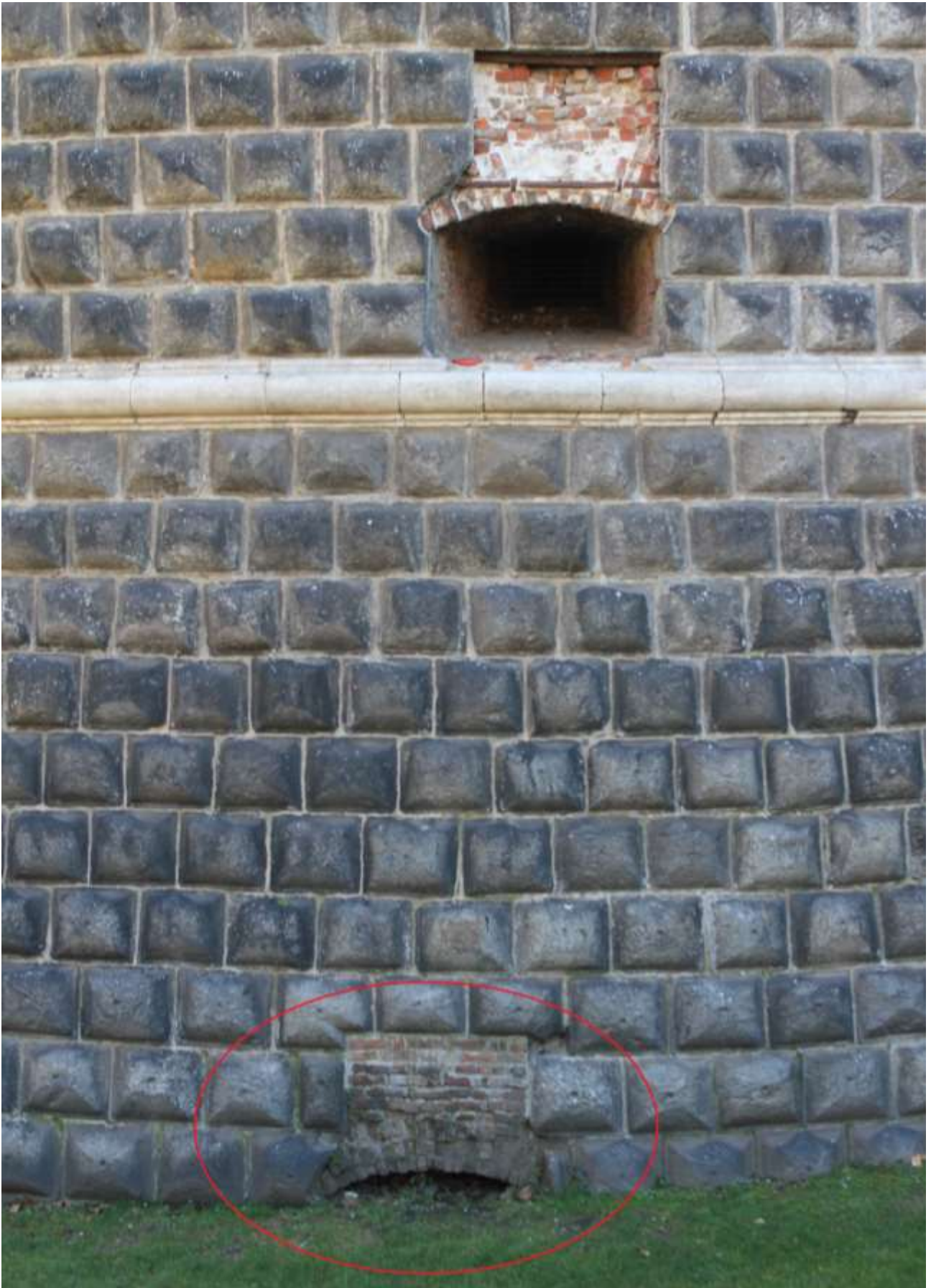
Fig. IX. 1. Torrione Sforzesco Est: si noti la feritoia inferiore quasi completamente occlusa (14 febbraio 2019).
