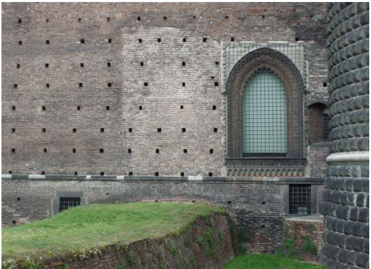
Fig. IX. 3. Cortina a chiusura del fossato a sud-ovest: la traccia sul muro del Castello indicherebbe la sua originaria altezza; rimane da capire cosa vi sia all'interno e cosa celi inferiormente (21 settembre 2004).
