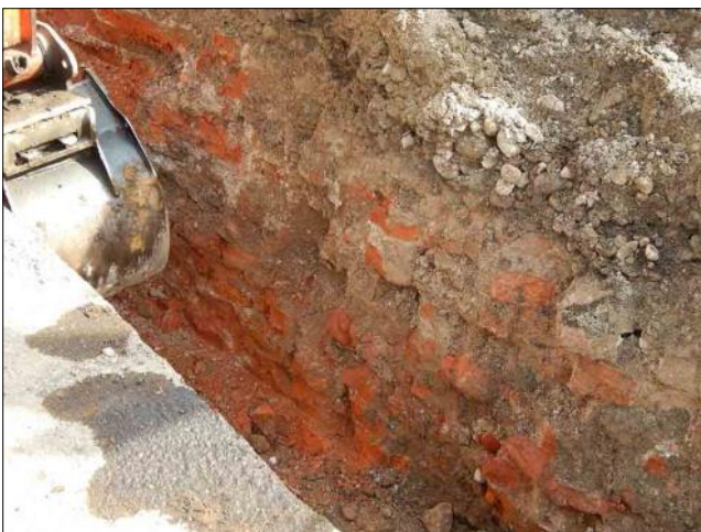
Fig. 50. Non si sta scavando in un cumulo di macerie, come qualche "somaro venerando" ha affermato, ma si sta "sbancando" il solido muro facente parte delle opere difensive del Castello di Milano.
