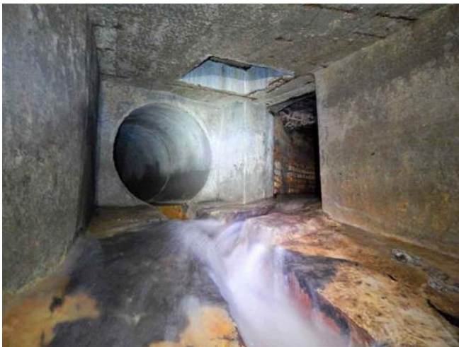
Fig. 57. La moderna fognatura intercetta e cancella le opere sotterranee del Castello.
