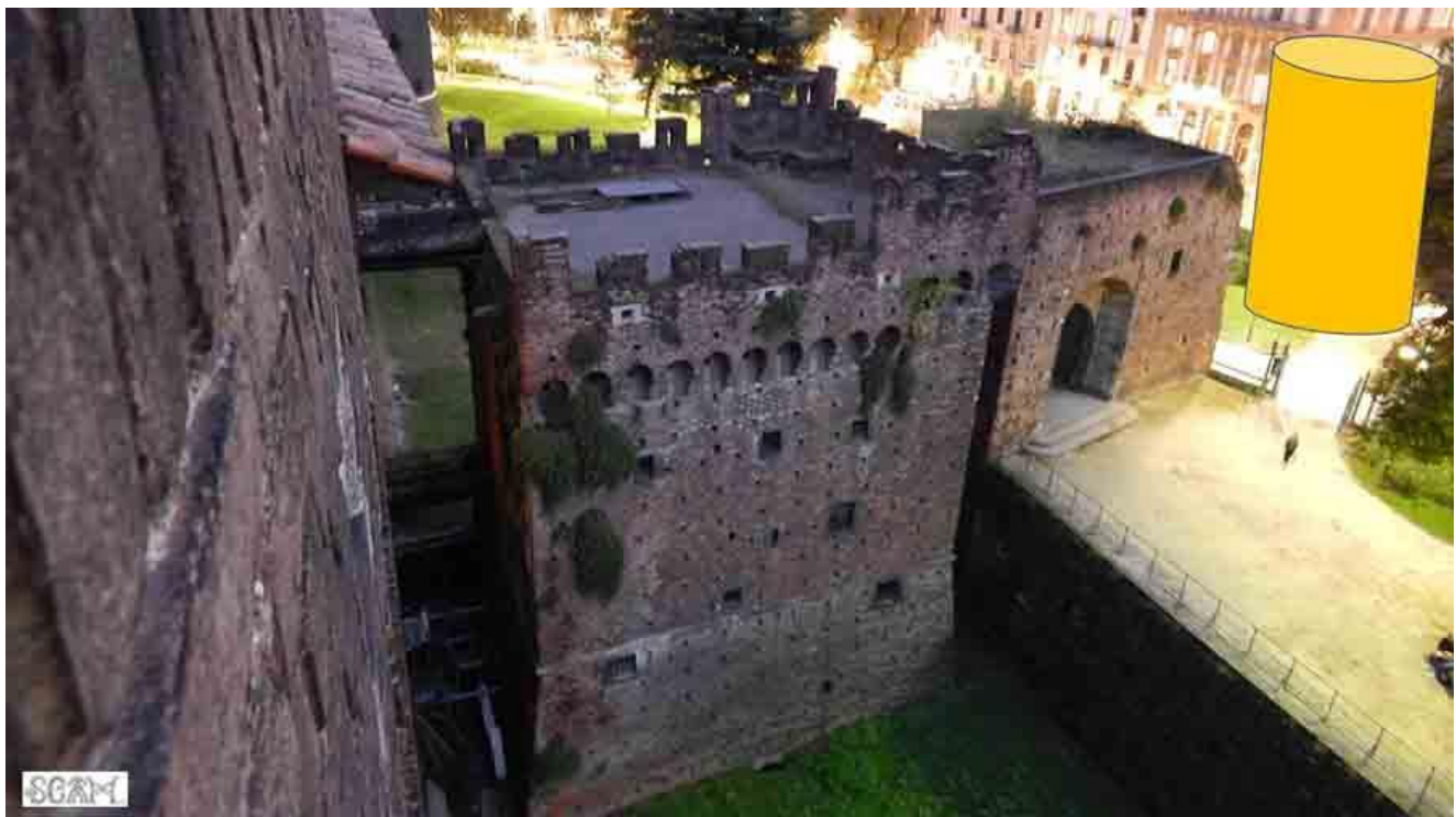
Fig. 38. Lato sudovest del Castello (da nord a sud): in primo piano abbiamo il Rivellino di Porta Vercellina, l'ala rientrante della Ghirlanda e la posizione che occupava la torre angolare a pianta circolare, di cui rimane nel sottosuolo almeno un piano intero (figura cilindrica gialla).
