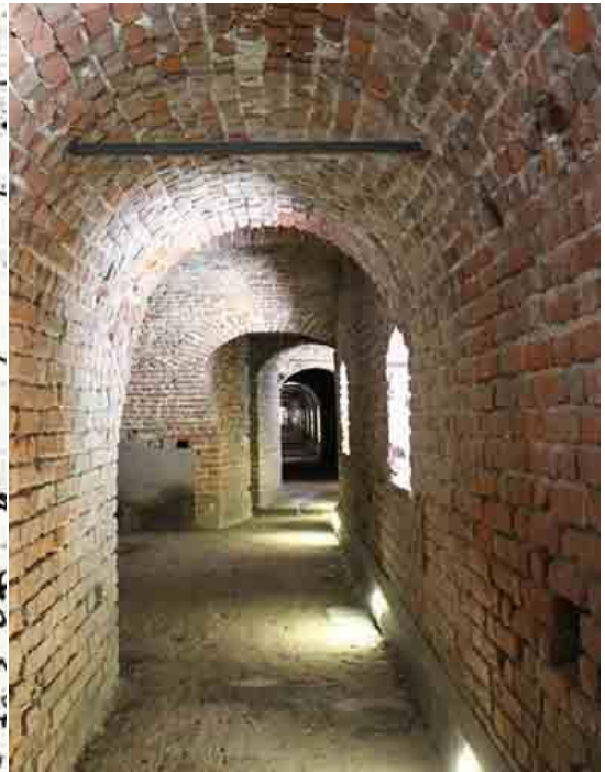
Fig. 27. S: "strada segreta di dentro" (così denominata da Leonardo da Vinci). Si tratta della Galleria di Controscarpa, opera unica al Mondo per l'epoca di costruzione e lo sviluppo di mezzo chilometro, con 103 finestrelle e una feritoia, nonché dodici diramazioni di collegamento in galleria.
