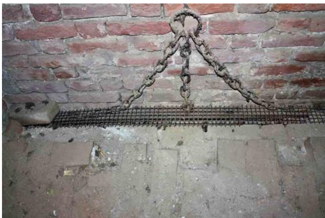
Fig. 42. Rivellino di Porta Vercellina: ecco una delle tre aperture a pavimento che consentiva di azionare la sottostante saracinesca (o cateratta), la quale scorre tra guide di granito. Questo è un ulteriore elemento di riprova che il Rivellino di Porta Vercellina sia solo ed esclusivamente un'opera medievale.
