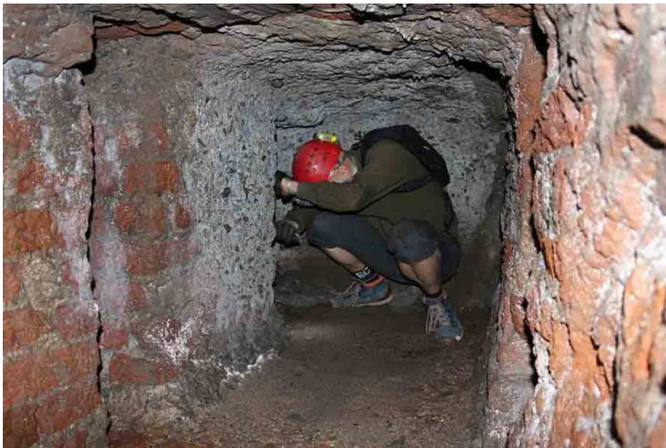
Fig. 26. Cunicolo di demolizione con due fornelli scavato in rottura di muro per la demolizione della Ghirlanda, rimasto inutilizzato.
