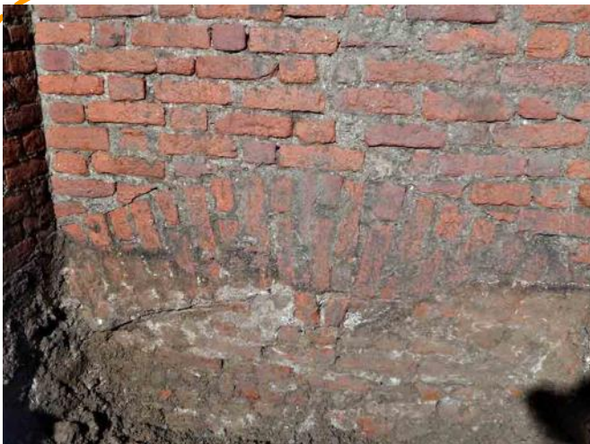
Fig. 65. Accesso murato al terzo livello sotterraneo. Quanti chilometri di sotterranei sono ancora celati al di sotto del Castrum Portae Jovis ?
