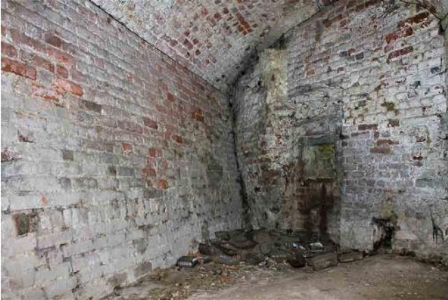
Fig. 24. Casamatta del secondo livello che teneva sotto tiro il fossato interno con "fuoco rovescio", ovvero dalla controscarpa verso il "corpo di piazza". La sua struttura avrebbe dovuto sollevare più di una esclamazione da parte di qualsiasi serio studioso di architetture militari medievali... ed essere pulita e non già tenuta come un immondezzaio.
