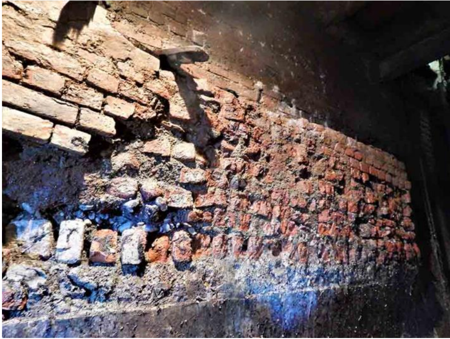
Fig. 60. Sfondamento del "passaggio segreto" nel punto in cui scendeva rapidamente di quota per poter passare al di sotto della casamatta situata nel secondo livello sotterraneo della Ghirlanda.
