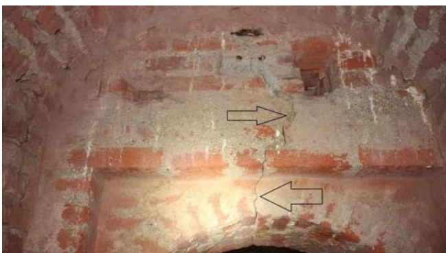
Fig. 88. Le frecce indicano i danni riportati dalla struttura a causa della ruspa.
