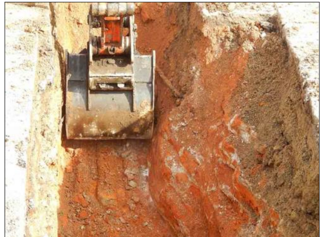
Fig. 49. La benna sta inequivocabilmente demolendo le murature antiche.
