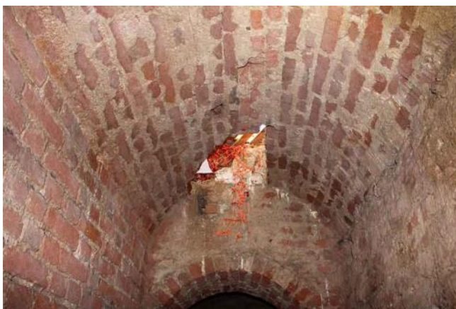
Fig. 87. Primo livello della Ghirlanda visto dall'interno e in corrispondenza dello sfondamento.
