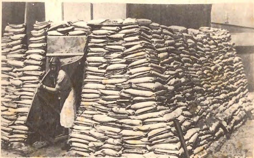
Rifugio improvvisato in Inghilterra con sacchetti pieni di sabbia. Si noti la tenda di cui deve essere munito l'ingresso di ogni rifugio, predisposto od improvvisato.
