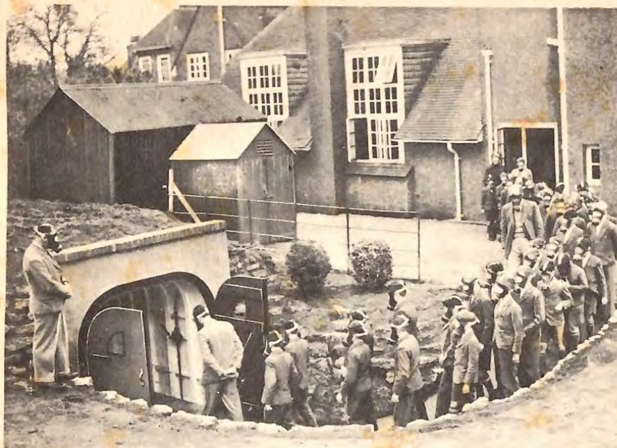
Allievi di un collegio inglese i quali, muniti di maschera antigas, entrano disciplinatamente nel rifugio allestito presso la scuola. Si noti la doppia porta a tenuta stagna, e, nello spazio fra una porta e l'altra, una pompa a mano per estrarre l'acqua che, in seguito ad eventuali rotture di condutture, irrompesse nel sotterraneo.
