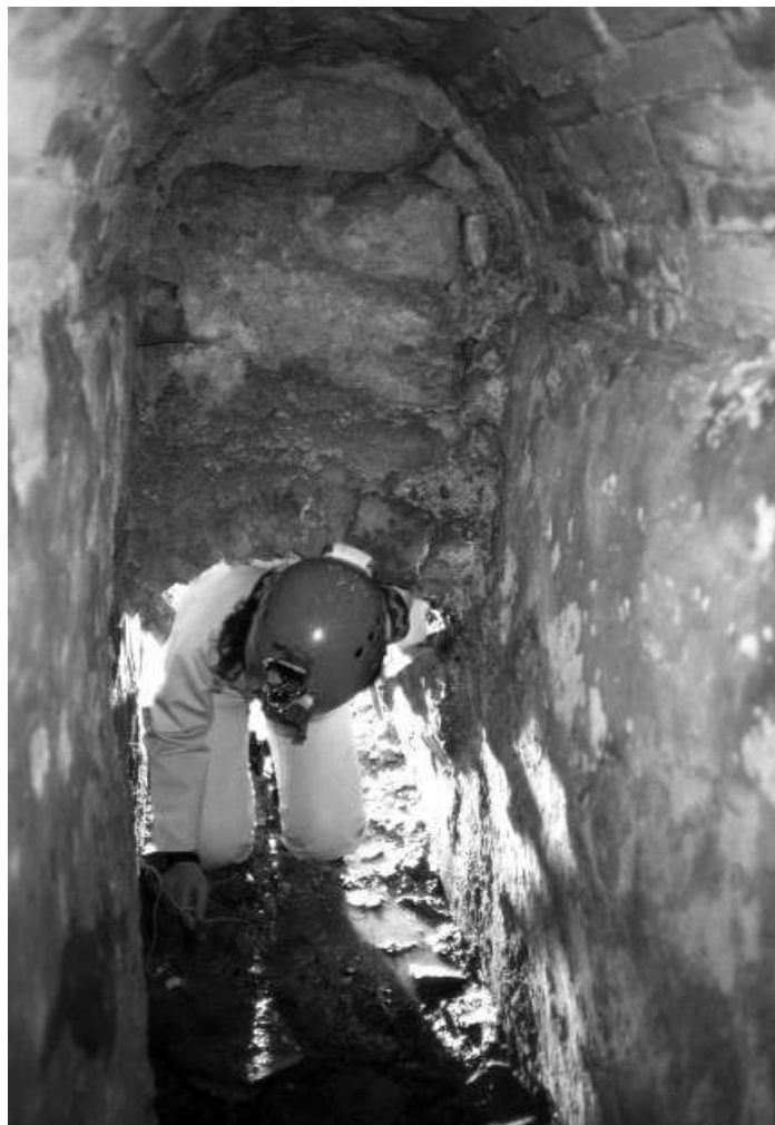
Fig 4. Fonte del Filello. Passaggio dalla cisterna al cunicolo di alimentazione.
