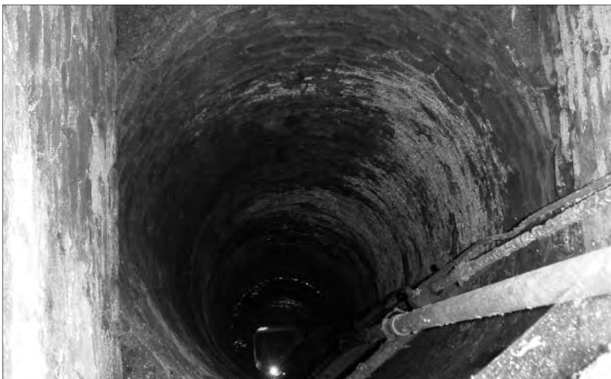
Fig. 3.4. Pozzo rivestito in muratura, all'interno del Castello di Vinzaglio (Novara); l'opera difensiva è costruita su di un terrazzamento fluviale. (Foto Archivio Ass.ne S.C.A.M.)
