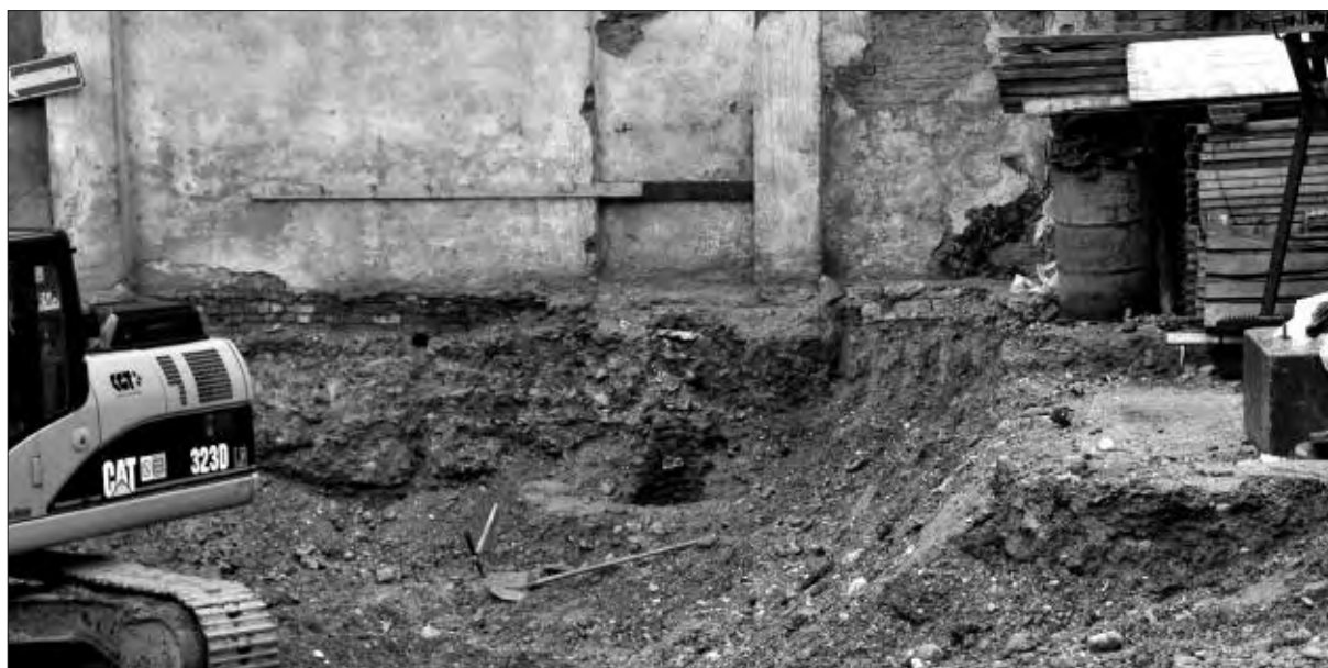
Fig. 1.3. Al posto dell'edificio abbattuto, prospiciente Villa Areati, si sta scavando per gettare le fondamenta di una nuova struttura. Al centro dell'immagine si scorge un pozzetto. (Foto di G. Padovan)
