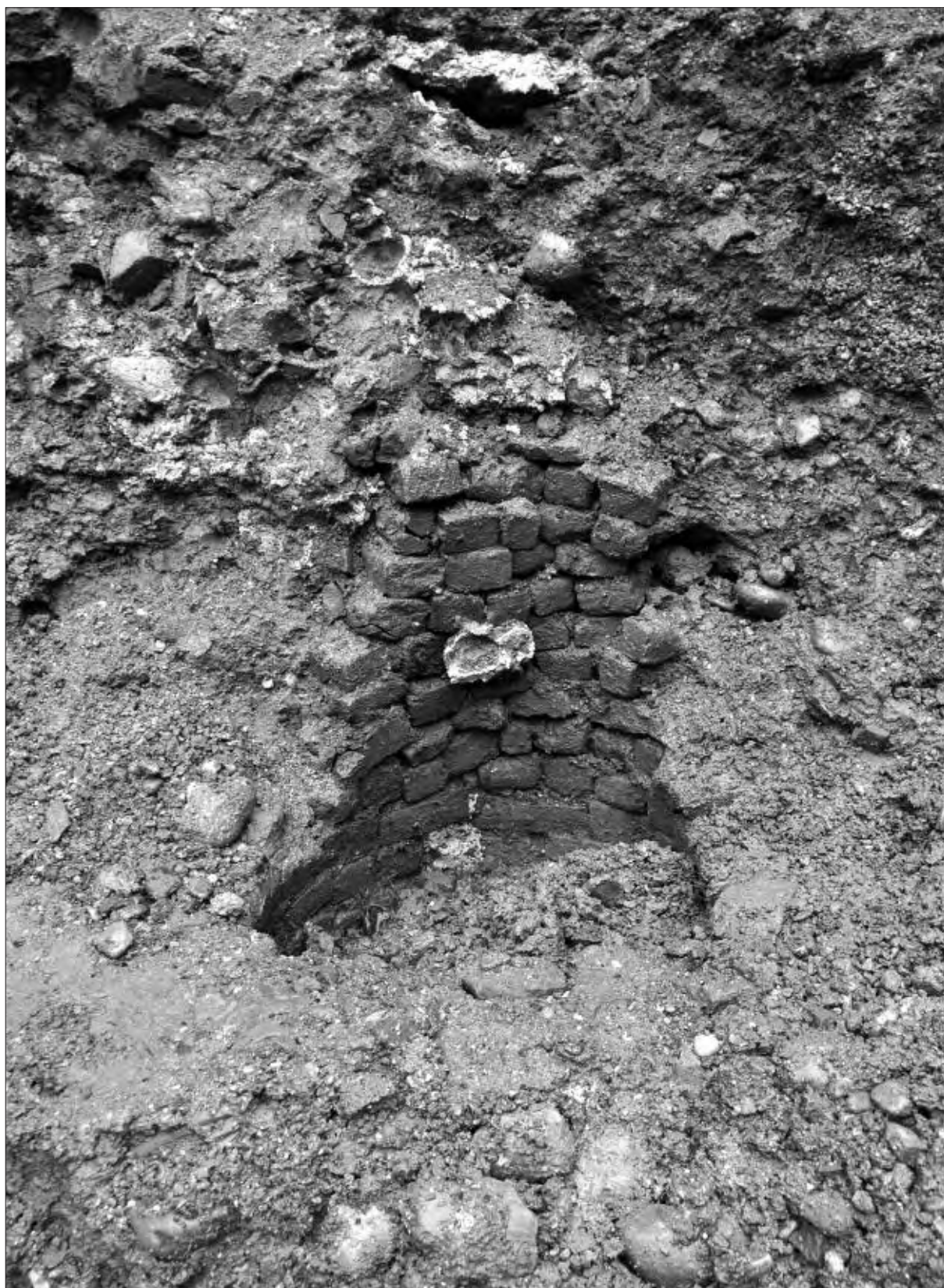
Fig. 1.4. Vista frontale di un pozzetto perdente in mattoni, rinvenuto in via Baldironi nel corso dello scavo per la gettata delle fondamenta di una nuova costruzione. (Foto di G. Padovan)
