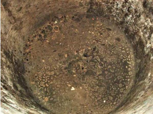
**Fig. 2.74 - Interno della neviera cilindrica: sul fondo si scorge il pozzetto rivestito di ciottoli per l'esfiltrazione dell'acqua di fusione.**
