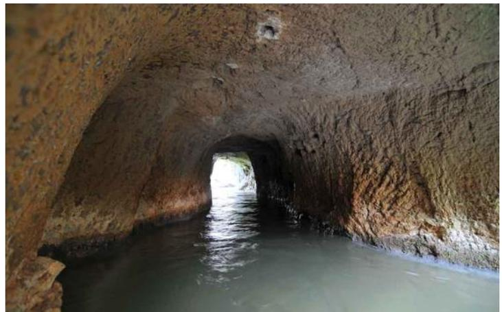
Fig. 2.14 - Galleria principale della Tagliata di Ansedonia; anche in quest'opera le tracce lasciate dagli attrezzi di scavo sono più che evidenti.
