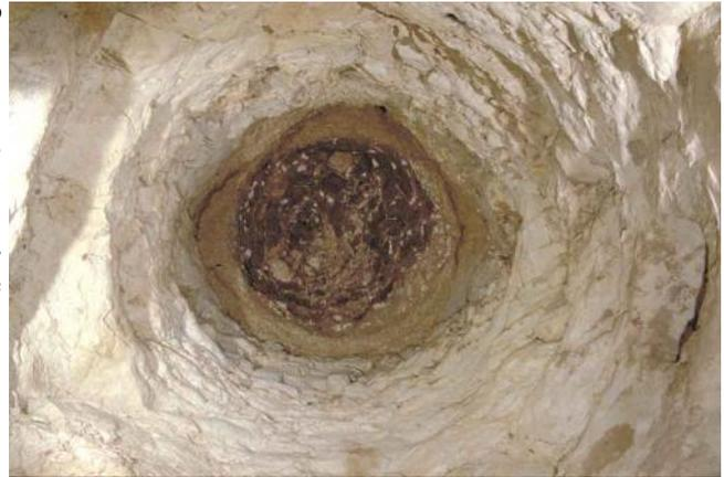
**Fig. 2.9 - Pozzo a sezione circolare scavato nelle marne e nelle arenarie, facente parte del cosiddetto "Acquedotto dei Piceni" (Marche); nel 2000 gli speleologi dell'Ass.ne S.C.A.M. ne hanno rilevato in dettaglio un tratto di 124.5 m. L'acquedotto è generalmente noto come "Buco del Diavolo", ma in realtà con tale nome si va ad indicare il solo cunicolo che è stato scavato a posteriori per intercettare l'antico condotto e deviarne l'acqua.**
