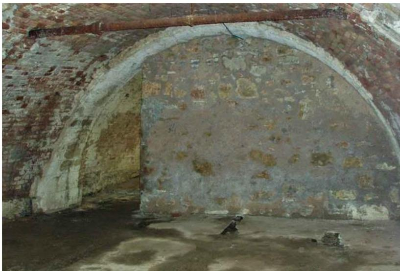
**Fig. 2.28 - Il torrente Garza è uno dei corsi d'acqua che attraversavano la città di Brescia fin dall'antichità. Oggi è stato deviato e all'interno del suo vecchio alveo oramai sotterraneo ed asciutto si è ricavato un ricovero antiaereo nel corso dell'ultima guerra mondiale. Nell'immagine si scorgono i resti di un vecchio ponte, inglobato nella volta di copertura. Oggi si può visitare con l'Associazione Brescia Underground.**
