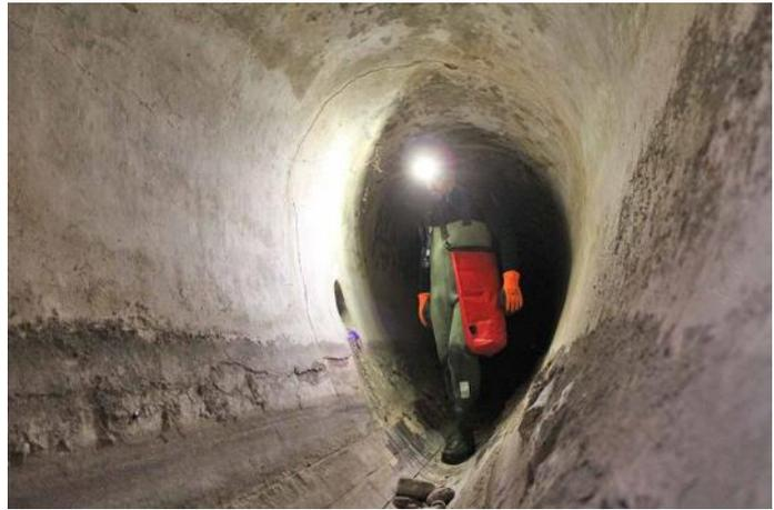
Fig. 2.89 - Fognatura a sezione ovoidale, dismessa, a Saronno.
