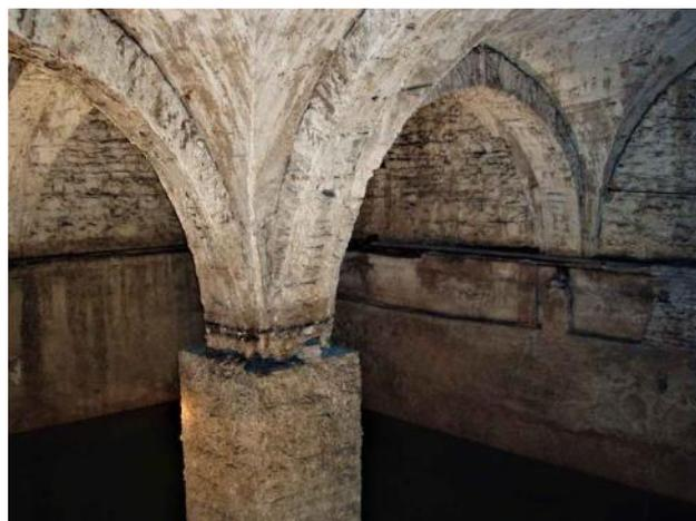
Fig. 2.62 - Fontana del Latér, situata a Bergamo Alta, alimentata da due sorgenti captate mediante condotti sotterranei in muratura.
