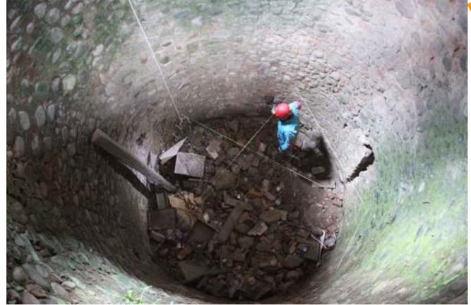
**Fig. 2.72 - Interno della Ghiacciaia del Castello San Giorgio: la volta è stata rifatta in tempi recenti, ma il fondo dell'opera troncoconica è colmo di macerie e spazzatura.**
