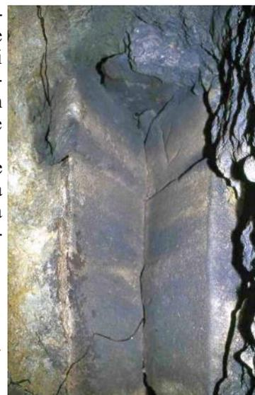
**Fig. 2.27 - Cunicolo con pozzetto a sezione rettangolare chiuso con lastre di "Macco Tarquiniese" poste a doppio spiovente; una riporta incisa una lettera dell'alfabeto etrusco. L'opera è situata presso la Civita di Tarquinia (Viterbo) nell'area antistante la cosiddetta "Porta Romanelli".**
