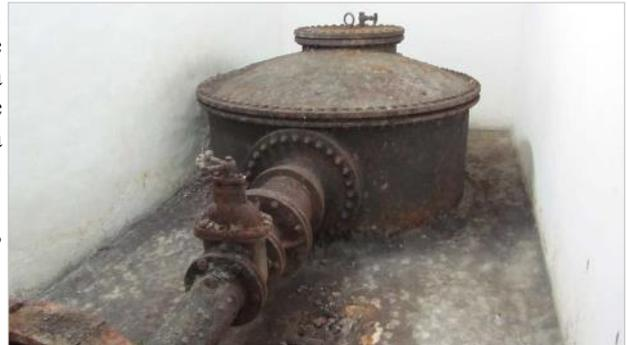
Fig. 2.46 - Impianto di sollevamento sotterraneo di un pozzo artesianiano dell'Acquedotto Civico di Milano.
