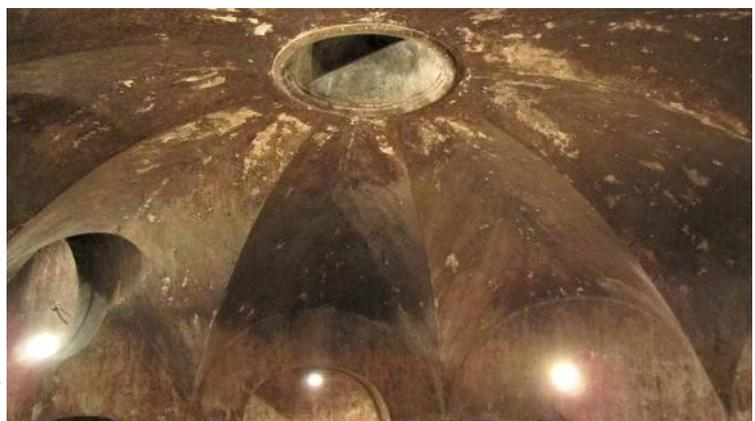
**Fig. 2.84 - Milano: volta a ombrello e oculo centrale del Collettore fognario Ponzio.**
