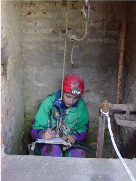
**Fig. 2.44 - Operazioni di rilievo all'interno del pozzo esterno del Castello di Vinzaglio (Novara). Interamente in mattoni, l'opera presenta la parte inferiore a sezione circolare, mentre quella superiore quadrangolare è verosimilmente frutto di un intervento successivo.**
