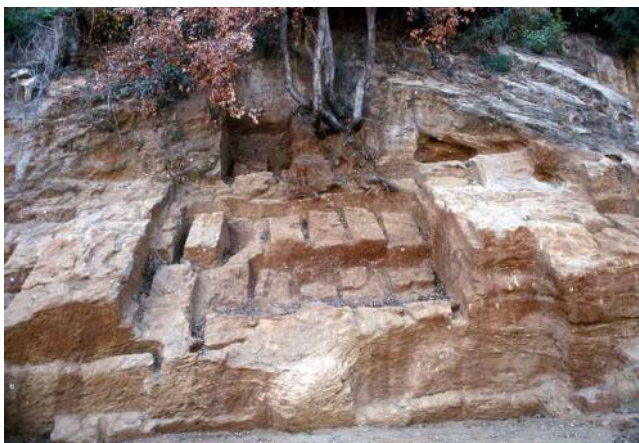
Fig. 1.41 - Antica cava situata nei pressi della città etrusca di Populonia (Livorno) da cui si estraevano i blocchi di materiale lapideo (calcarenite) da costruzione.
