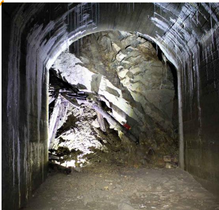
Fig. 1.59h - La conoscenza delle armature utilizzate nelle coltivazioni minerarie può essere utile anche nello studio di talune opere del Vallo Alpino Occidentale (La Thuile). L'immagine inquadra il fondo di un ambiente abbastanza ampio in cui si apre una galleria lasciata allo stato di avanzata, ancora armata con i quadri lignei, riscontrabili in talune miniere della zona.
