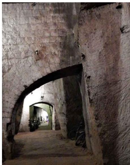
Fig. 1.30 - Cava sotterranea di materiale lapideo, parzialmente riutilizzata come opera di percorrenza alla metà dell'Ottocento e negli Anni Settanta del secolo successivo come Deposito Giudiziale Comunale; oggi è stata resa visitabile ed è nota come "Galleria Borbonica". In primo piano si noti la struttura in muratura con la sorta di "arco rampante" che, senza interrompere la viabilità, contrasta le spinte delle pareti di cava.
