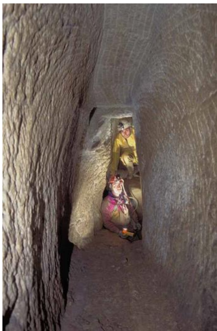
Fig. 1.54 - Antro delle Gallerie (Varese) denominato "La Sfinge della Valganna" nel XIX secolo: galleria laterale del complesso ipogeo scavato nell'arenaria quarzosa. Si notino i solchi lasciati sulle pareti e sulla volta dal così detto "scalpello immanicato" rappresentato in "Fig. 1.4". La F.N.C.A. ha pubblicato il libro: "Antro delle gallerie, indagini di Archeologia mineraria in Valganna (Varese)".
