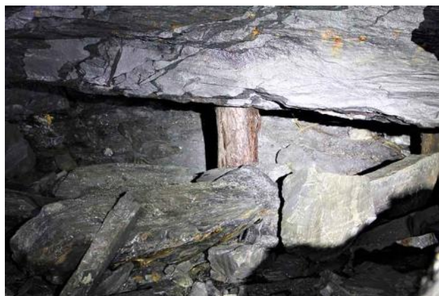
Fig. 1.58 - Puntello ligneo in una miniera di antracite abbandonata, situata nel territorio di La Thuile (Valle d'Aosta).
