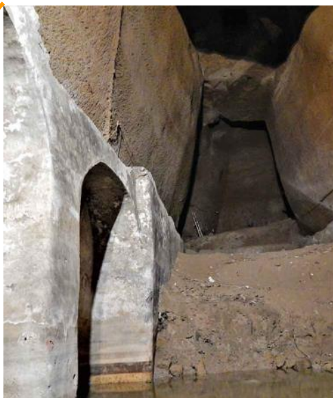
Fig. 1.29 - Napoli: cava sotterranea parzialmente interrata.
