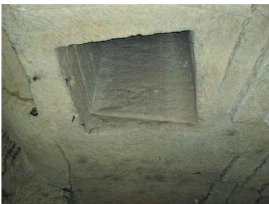
Fig. 1.43 - Cava di Colma a Rosignano (Alessandria) coltivata "a camere e pilastri": camino d'aerazione ed estrazione. Si noti come le pareti della cavità conservino le tracce di scavo lasciate dagli attrezzi e dal progressivo distacco dei conci.
