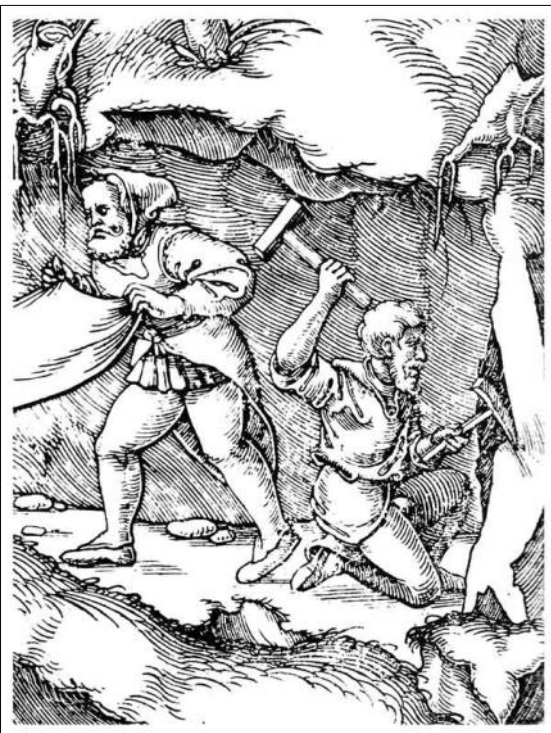
Fig. 1.4 - Minatore che demolisce la roccia mediante uno scalpello curvo immanicato, battuto mediante un martello: in fase di scavo di un cunicolo, sia esso di percorrenza, d'acquedotto o altro, lo strumento lasciava sulle pareti delle solcature curve e parallele (Agricola G., De re metallica. Libri XII, Basileae 1550).
