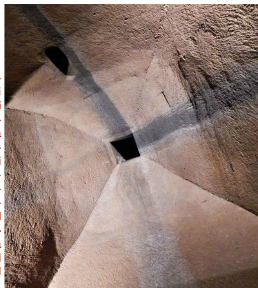
Fig. 1.32 - Napoli: volta di una cisterna di grandi dimensioni ricavata da una preesistente cava di materiale lapideo da costruzione. Al culmine abbiamo il pozzo attraverso cui si calava la secchia per il prelievo del liquido.
