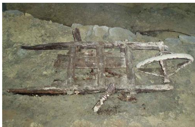
Fig. 1.46 - Carriola lignea per il trasporto dei conci nella cava di Colma di Rosignano (Alessandria).
