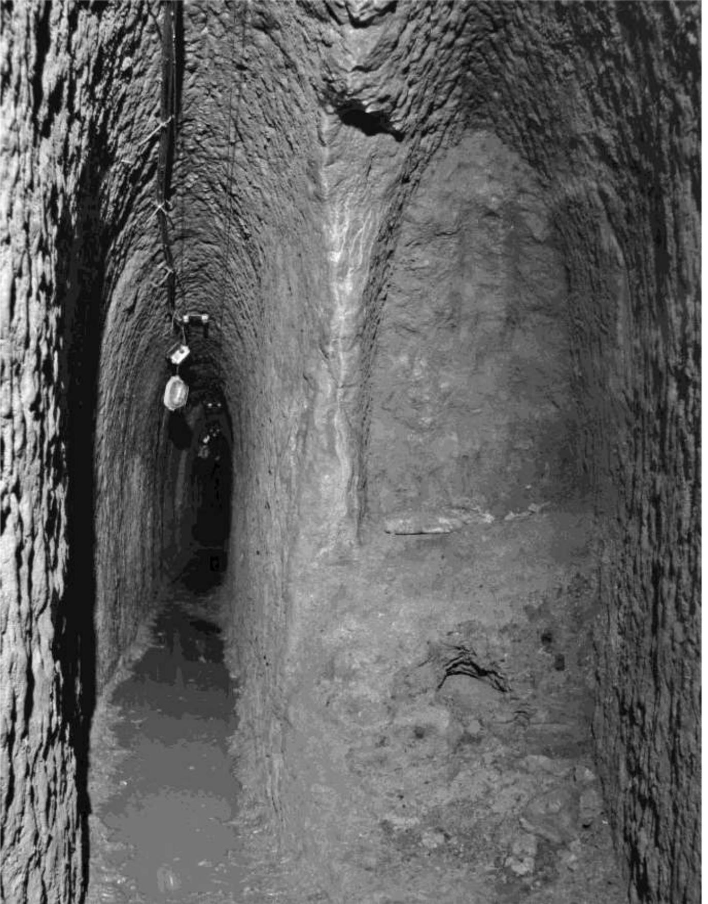
Fig. 8. *Condotto idraulico arcaico. La traccia del condotto di destra permette di realizzare come avvenisse la tecnica di scavo. Veniva scavata prima la metà superiore e dopo quella inferiore facendo attenzione a dare la giusta pendenza.*
