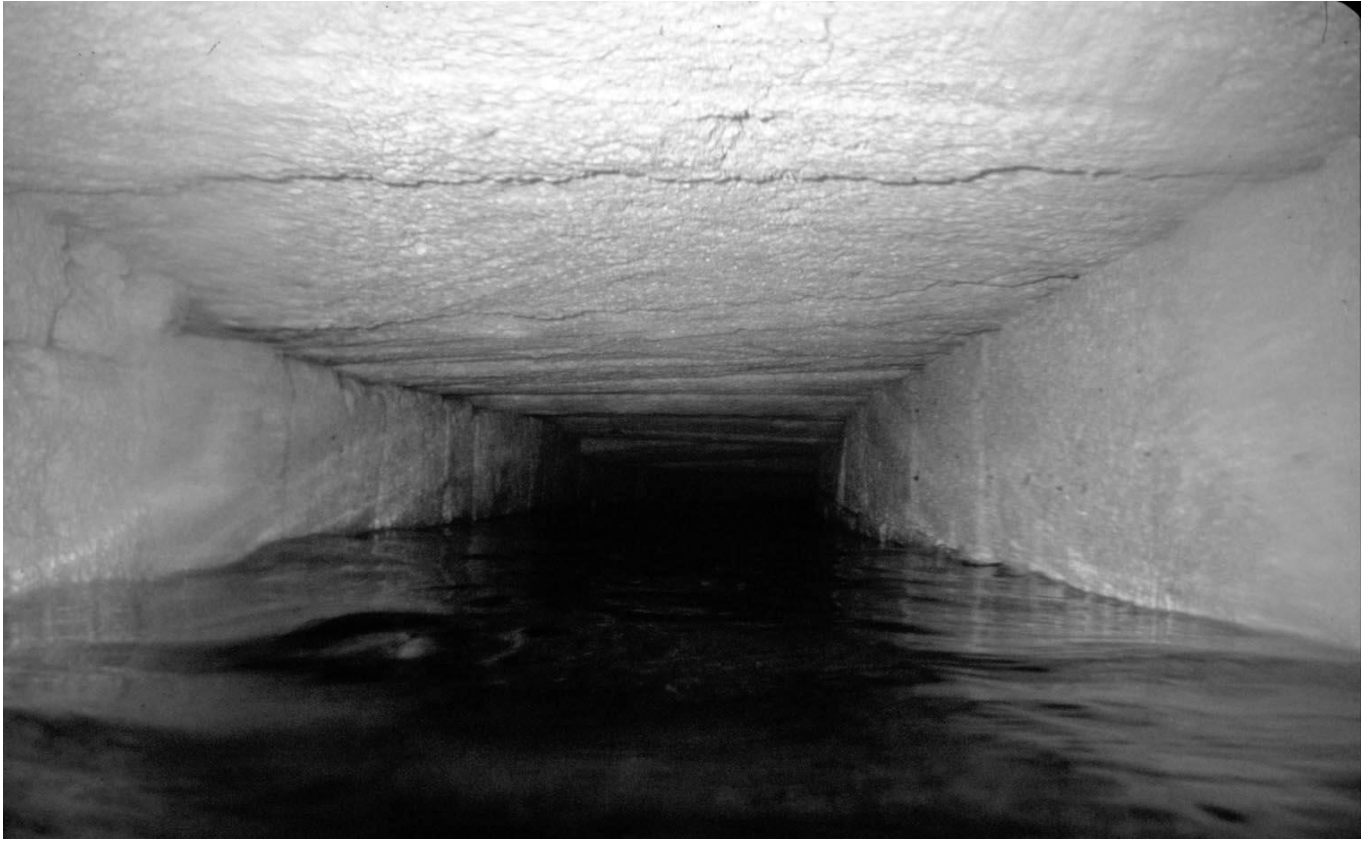
Fig. 7. 1995: tratto sifonante prima dell'abbassamento del livello dell'acqua nel cunicolo.
