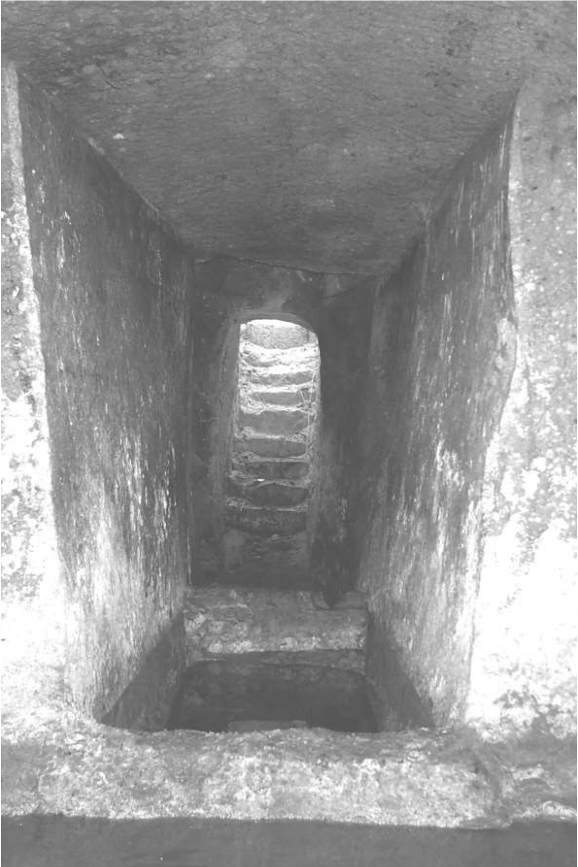
Fig. 16. Interno della Cisterna del Grillotalpa, CA 00017 LA VT (foto E. Franzoni).
