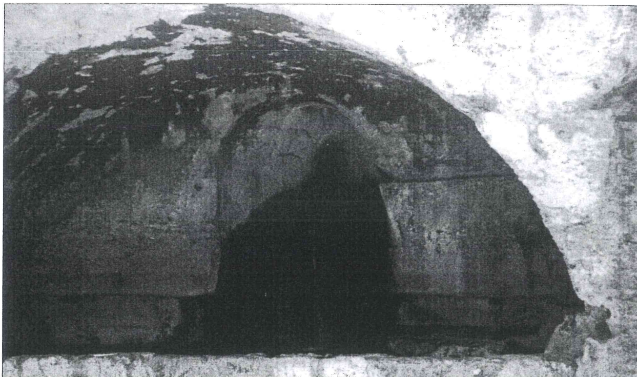
Siracusa. Lo sbocco dell'acquedotto del Paradiso nel Ninfeo sopra il teatro (foto I. Riera).
