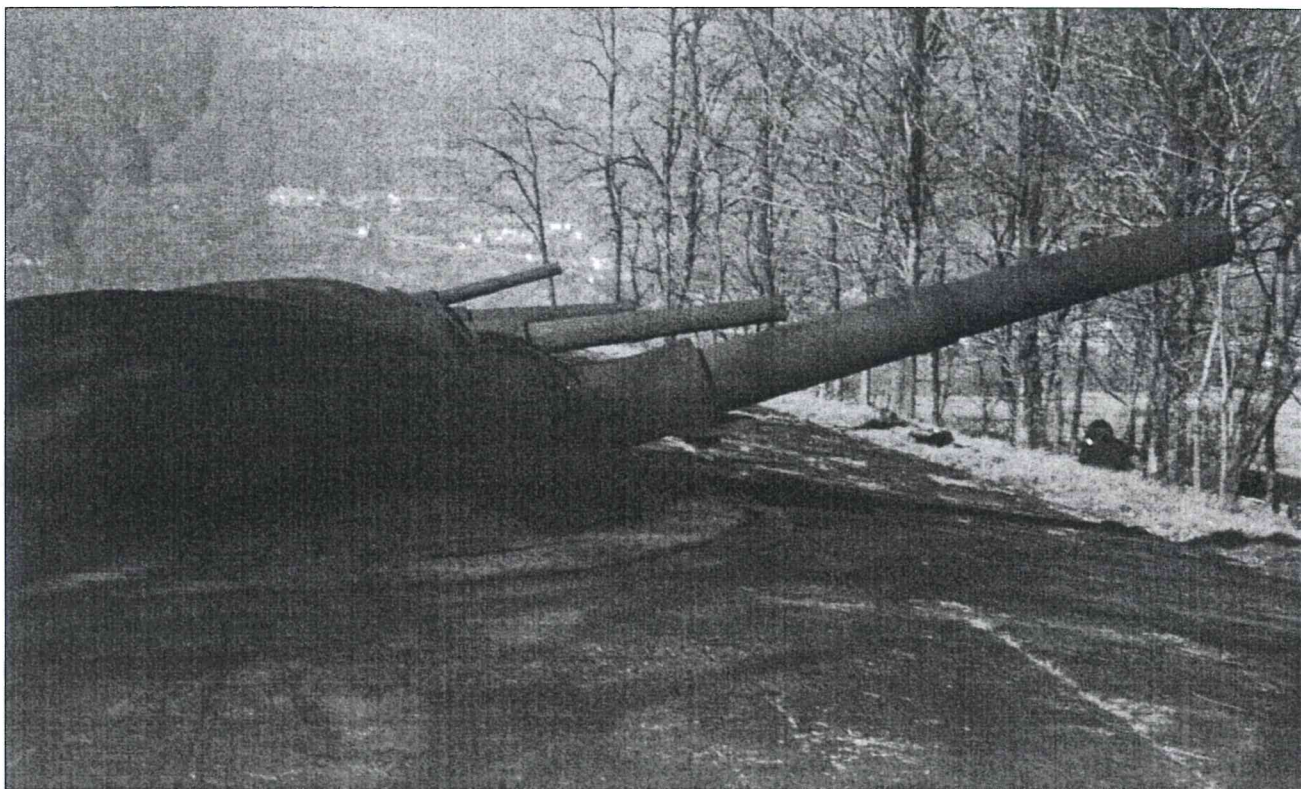
Cupole blindate del Forte di Montecchio, a nord di Colico (LC) (foto G. Padovan).
