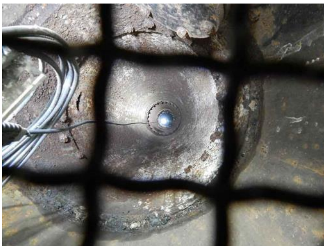
Fig. 48. Interno del pozzo d'epoca nella Centrale di pompaggio Armi.
