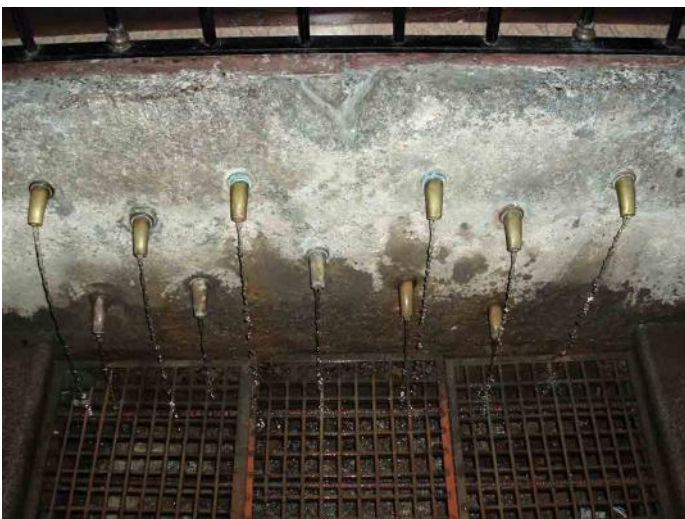
Fig. 20. Lastra di fonte con undici cannelle della Chiesa primigenia di Santa Maria alla Fontana.
