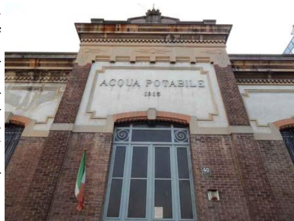
Fig. 66. Facciata della Centrale di pompaggio Anfossi.
