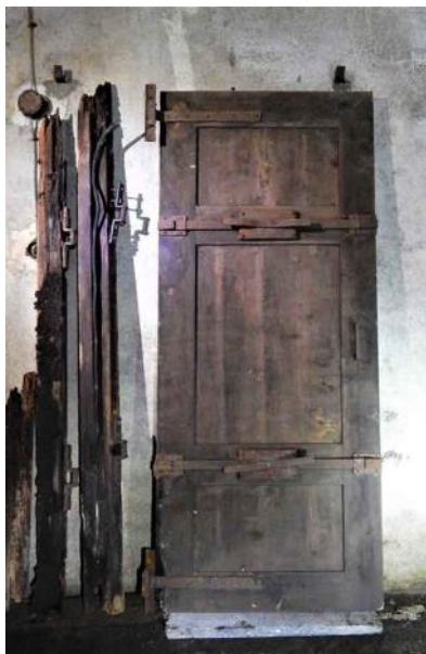
Fig. 64. Inusuale porta "antigas" in legno del rifugio antiaereo della Centrale di pompaggio Ascanio Sforza.
