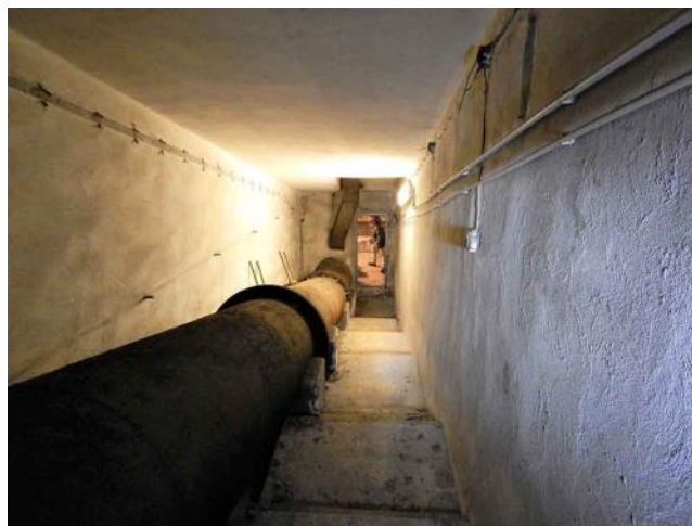
Fig. 95. Tubatura proveniente dal pozzo radiale, in disuso.
