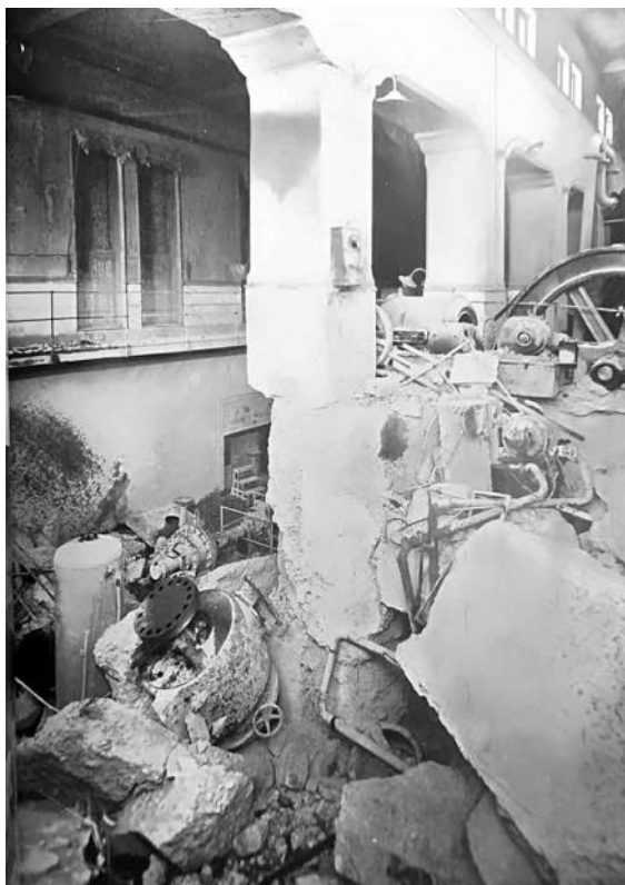
Fig. 44. Centrale di pompaggio Armi: danni riportati a seguito del bombardamento aereo dell'agosto 1943 (Amerigo Belloni, L'acquedotto milanese. L'approvvigionamento idrico della Città di Milano dal 1892 al 1951, Ulrico Hoepli Editore, Milano 1952, p. 51).
