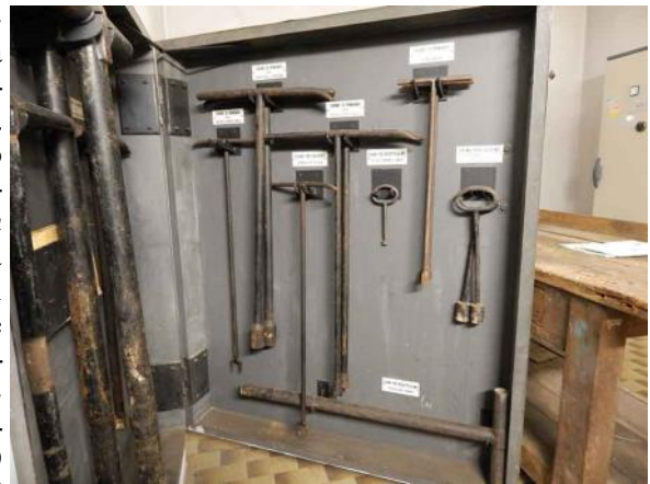
Fig. 87. Armadio metallico contenete gli attrezzi un tempo indispensabili custoditi nella Centrale di pompaggio Ovidio.
