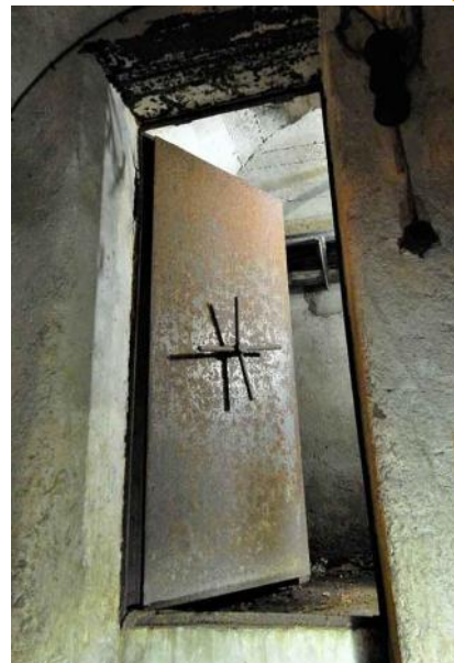
Fig. 65. Semplice porta metallica "antigas" ancora nella sua sede, nel rifugio antiaereo della Centrale di pompaggio Ascanio Sforza.
