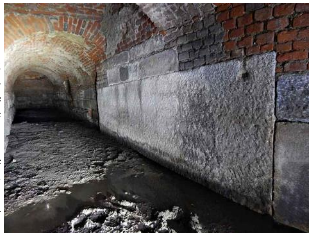
Fig. 27. Roggia Castello era uno dei due canali di alimentazione dell'Arena, spazio pubblico inizialmente destinato alle naumachie e ai giochi acquatici; lo studio delle opere ipogee dell'Arena sono in: Padovan Gianluca, Castrum Portae Jovis Mediolani. Il Castello Visconteo-Sforzesco di Milano dai disegni di Leonardo da Vinci all'Archeologia del Sottosuolo, Hypogean Archaeology (Research and Documentation of Underground Structures) N°14, British Archaeological Reports International Series 2949, Oxford 2019.
