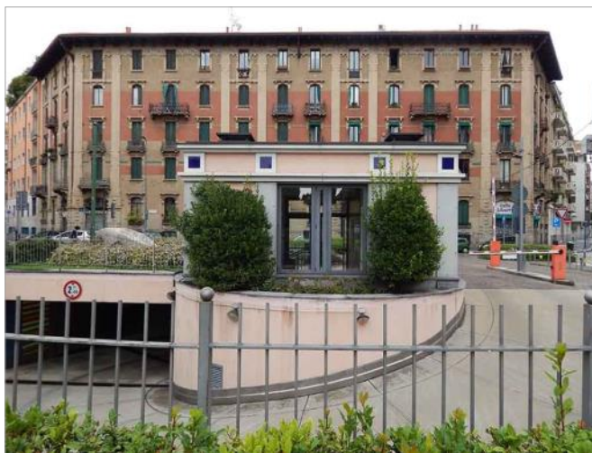
Fig. 41. Sul sedime della Centrale di pompaggio Benedetto Marcello è stato realizzato il parcheggio sotterraneo di uno dei condomini che si affacciano sulla grande strada.
