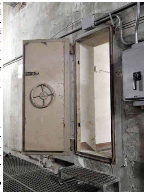
Fig. 96. Portello a tenuta stagna all'interno dell'impianto di Testi.
