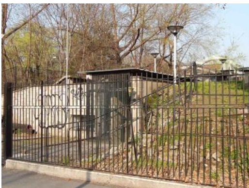
Fig. 56. Ingresso della Centrale di pompaggio Parco, in Viale Elvezia.
