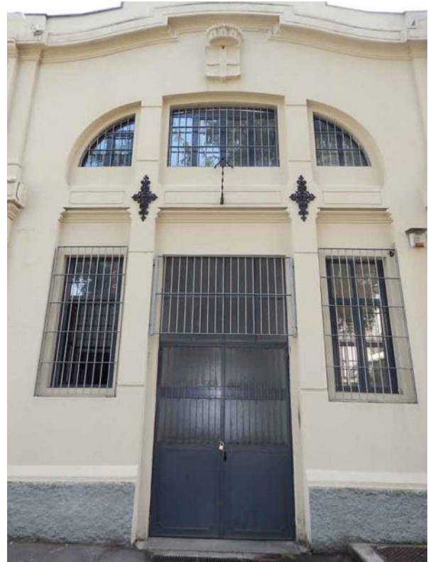
Fig. 45. Facciata originaria, restaurata, della Centrale di pompaggio Armi.
