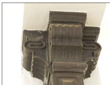
Fig. 57. Capitello del pilastro in ghisa conservato a seguito della ristrutturazione dell'edificio.
