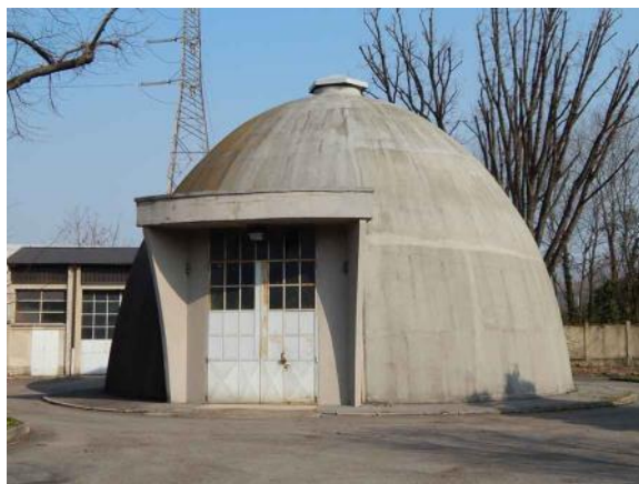
Fig. 93. Cupola di copertura del pozzo radiale della Centrale di pompaggio Platone ai giorni nostri.
