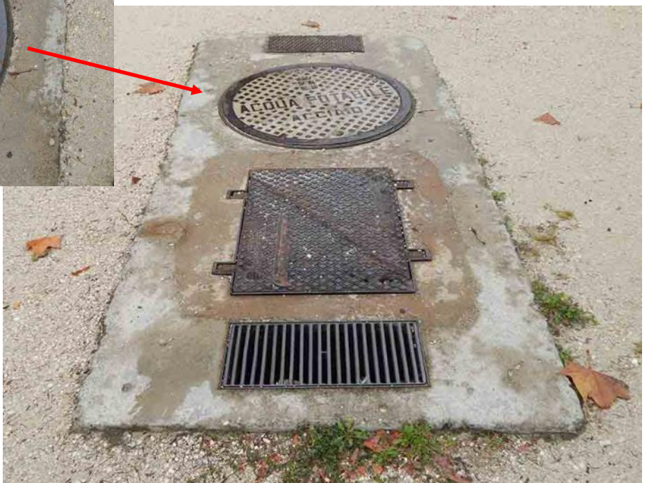
Fig. 9. Tombino a chiusura di un vecchio pozzo trivellato situato accanto all'Arca Civica. Accanto, (fig. 10) un dettaglio del tombino circolare a chiusura del vecchio pozzo.
