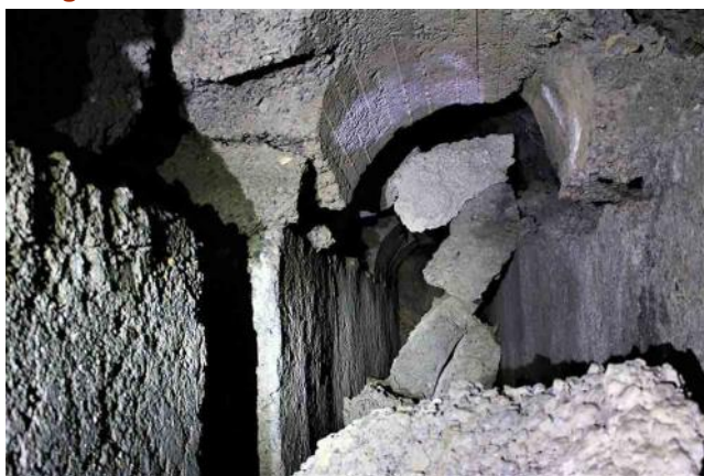
Fig. 33. Valle d'Aosta: opera in caverna del Vallo Alpino parzialmente demolita.
