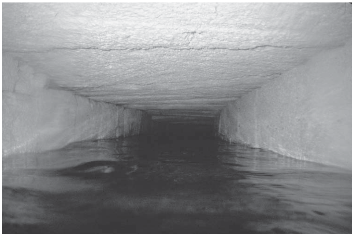
Immagine n. 2. Tratto di speco rifatto in blocchi di Macco tarquiniese nel XIX° sec.
