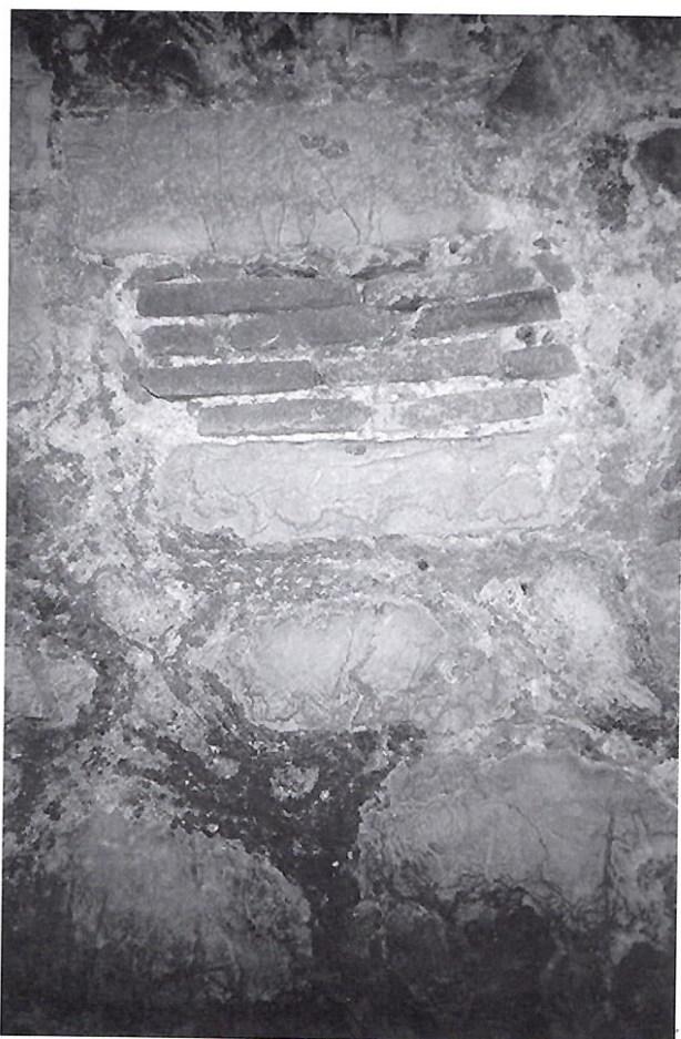
Foto 8 – Cisterna del Muro o dell'Arco (CA 01006 TO LI). Particolare della parete, con una pedarola rettangolare, successivamente tamponata con laterizi. (Foto G. Padovan)
