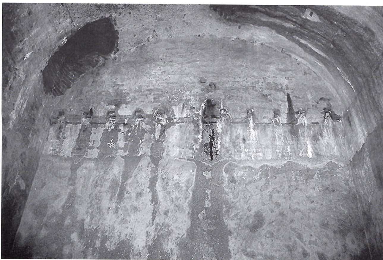
Foto 4 – Cisterna della Chiesa di San Fiorenzo (CA 01003 TO LI). Lato sud della camera di conserva: si notano le due aperture sulla volta e le bocchette d'adduzione. (Foto A. Gigliuto)
