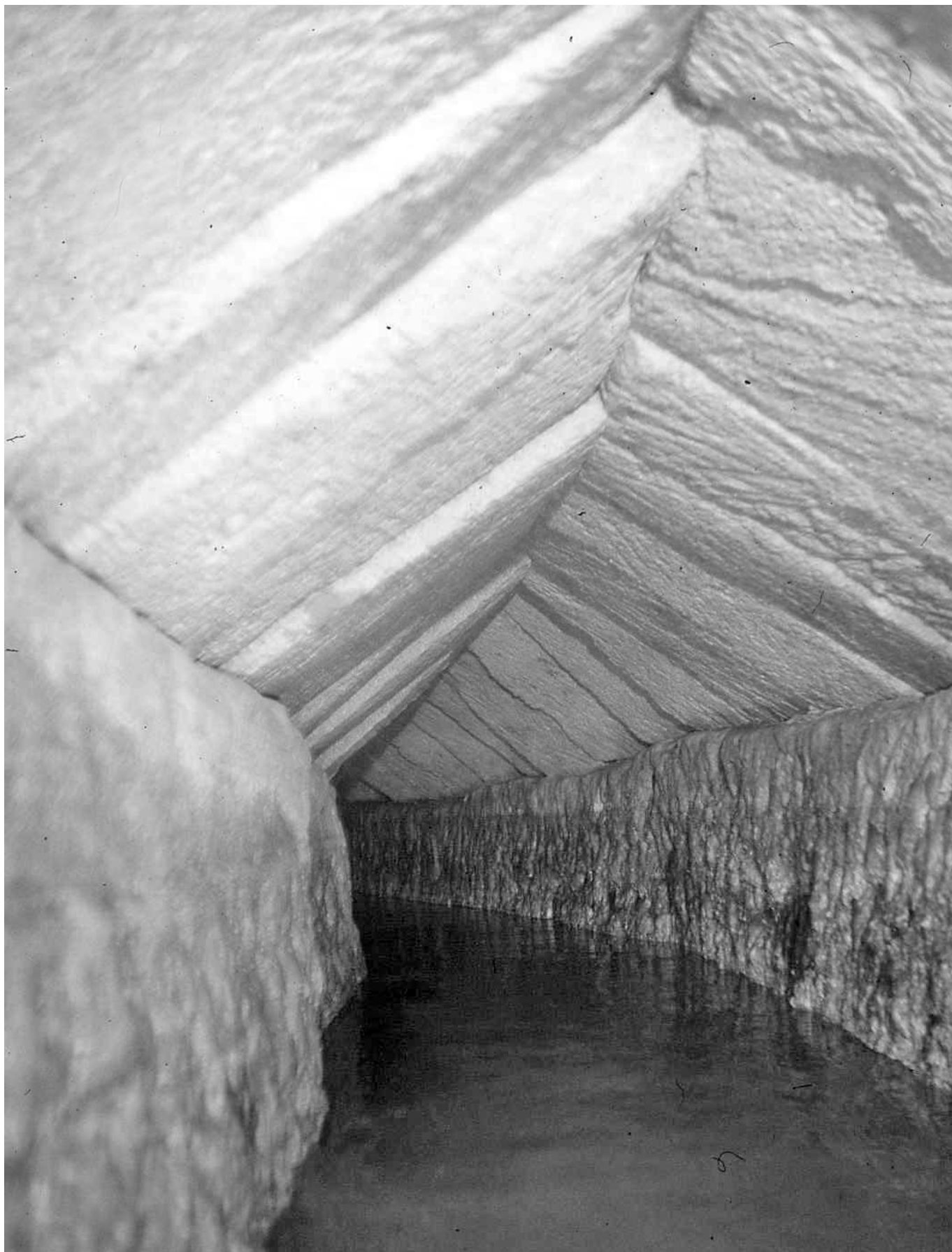
Fig. 9. Copertura a doppio spiovente in conci di macco.
