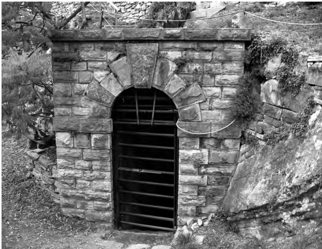
Fig. 14. Accesso ad un'opera in caverna situata al di sotto del recinto principale del Castello di Vezio. È composta da quattro piccole postazioni dotate di feritoia riquadrata in cemento, rivolte verso il lago e la sponda di Menaggio. (Foto M.A. Breda)
