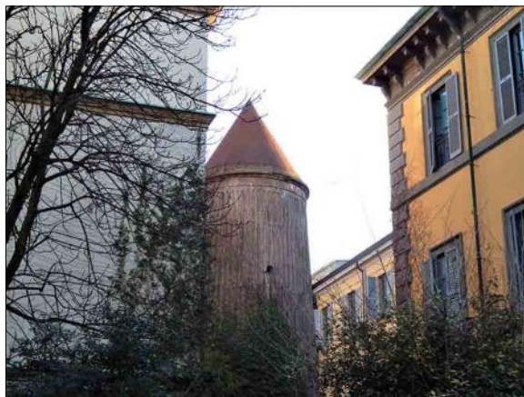
Fig. 1. Il bunker in elevato situato tra Palazzo Diotti (già sede della Regia Prefettura) a destra e Palazzo Isimbardi (già sede della Provincia di Milano) a sinistra.
