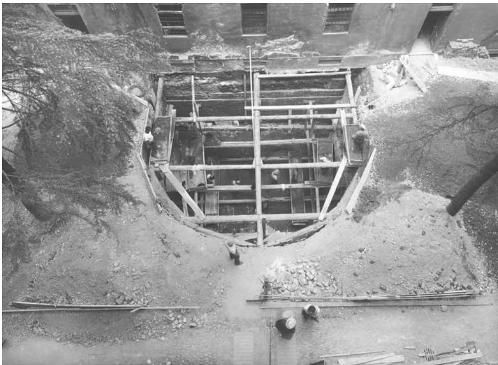
Fig. 16. 1939: fossa di fondazione del rifugio antiaereo di tipo speciale in elevato, primo bunker della Regia Prefettura di Milano, poi denominato "Torre delle Sirene" (Archivio Storico della Provincia di Milano).
