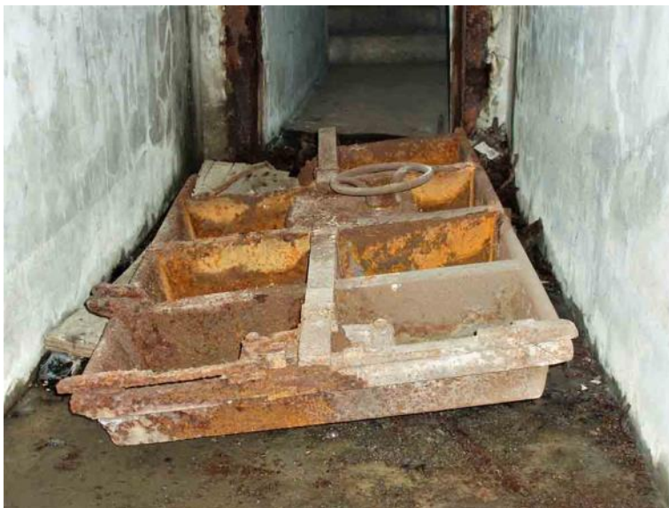
Fig. 53. Porta "antiscoppio" che chiudeva l'accesso al primo piano sotterraneo.
