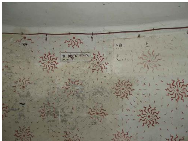
Fig. 25. La parete è caratterizzata dal cosiddetto “sole sforzesco”, scelto dal Prefetto come motivo dominante da applicare agli interni della Torre delle Sirene.
