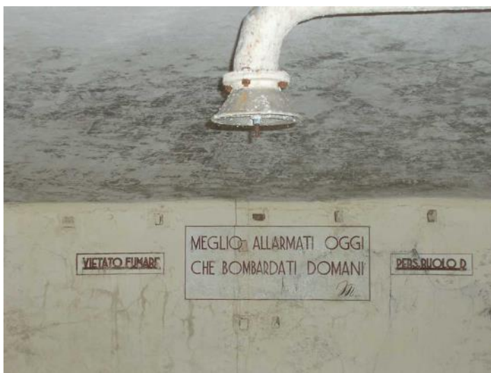
Fig. 33. Secondo piano sotterraneo della Torre: scritta voluta dal Prefetto e presente in ogni piano. Si noti il tubo metallico per l'aria terminante con il diffusore.
