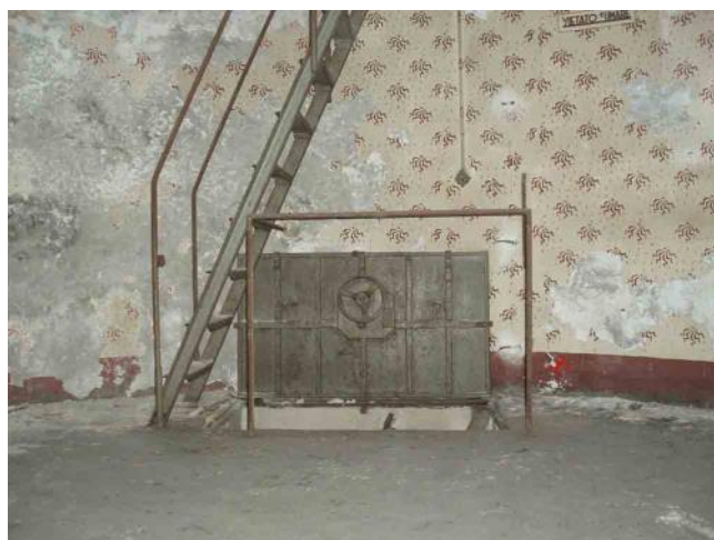
Fig. 50. Si noti come l'angolo sinistro superiore del portello sia bloccato dalla scala metallica fissa. Inizialmente il passaggio tra un piano e l'altro era garantito da scale di legno amovibili.
