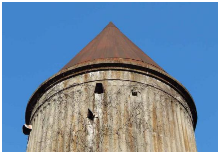
Fig. 20. Dettaglio della cuspid rivestita in metallo della Torre delle Sirene.
