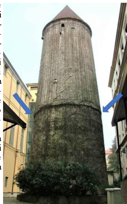
Fig. 29. Parte inferiore della Torre delle Sirene: si notino le tracce lasciate dall'asportazione del rivestimento in marmo fino al sesto metro fuori terra.
