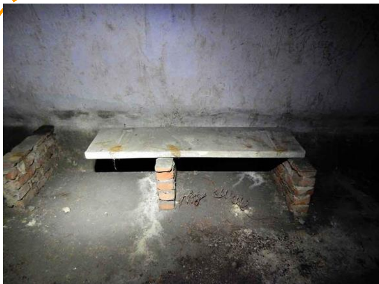
Fig. 13 - Rifugio antiaereo del Quartiere Ettore Ponti a Milano: le sedute sono in tavole di graniglia appoggiate su supporti in muratura.
