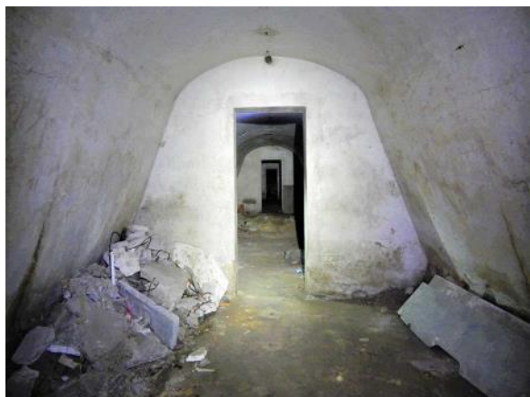
Fig. 1a - Rifugio antiaereo del Quartiere Ettore Ponti a Milano: è in calcestruzzo non armato e con il cervello di volta situato a poco meno di due metri al di sotto della quota del soprastante vialetto con giardino.
