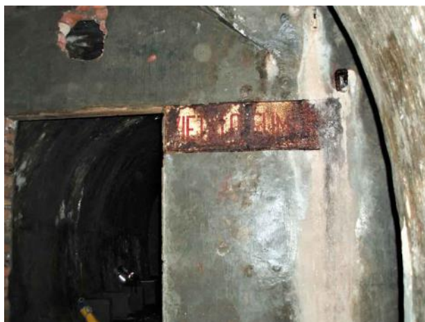
Fig. 20 - Dalmine (Bergamo), Rifugio Antiaereo Da Vinci, situato a 20 m di profondità: cartello metallico d'epoca ancora presente all'interno del grande rifugio antiaereo fatto costruire dalla ditta Dalmine a servizio del proprio quartiere operaio denominato "Leonardo da Vinci".
