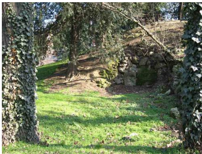
Fig. 24 - Milano, Quartiere Gorla, parco di "Villa Batthyany – Ottolenghi – Finzi": l'ingresso principale della grotta artificiale annessa al Tempio della Notte è murato da decenni. Ben pochi ricordano che sia stata utilizzata come rifugio antiaereo.
