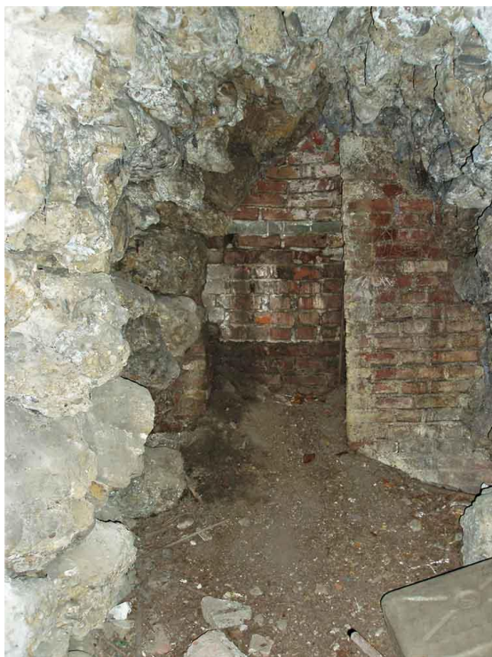
Fig. 30 - Ingresso ovest della grotta artificiale adeguato con muretti di mattoni la cui funzione doveva essere "antisoffio" e "paraschegge".
