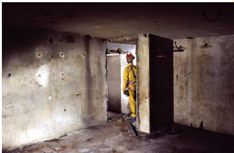
Fig. 6 - Bunker del Comando 52° Corpo dei Vigili del Fuoco di Milano, costruito nel 1943 e dismesso solamente negli Anni Cinquanta. Lo speleologo dello S.C.A.M. è nel vano oramai privo della porta antiscoppio. L'accesso non è dotato di spazio "antiricovero" e nemmeno della seconda porta metallica, ma solo di uno spesso muro in cemento armato con funzione "parasoffio" e "paraschegge" (Archivio Ass.ne S.C.A.M.).
