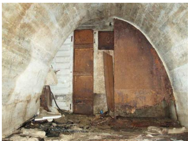
Fig. 47 - Sesto San Giovanni (Milano): rifugio antiaereo di tipo tubolare in solo cemento per gli operai della ditta Puricelli Strade; in primo piano vi è il paravento metallico con dietro il bugliolo.
