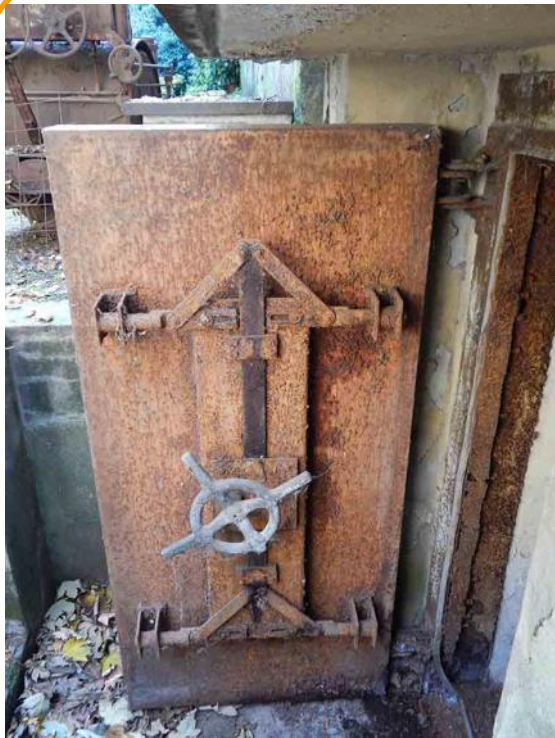
Fig. 5 - Milano, Corso Monforte: Bunker della Regia Prefettura e della Provincia. Costruito nel 1943, il rifugio antiaereo su due piani è in cemento armato, a prova di bomba e di aggressivo chimico. Il piano superiore è chiuso all'esterno mediante due spesse porte "antiscoppio" e a tenuta stagna della ditta Fichet. Sono entrambe sollevate da terra, hanno il pesante telaio metallico dotato di guarnizione e all'esterno sono superiormente protette da un tettuccio in cemento armato.
