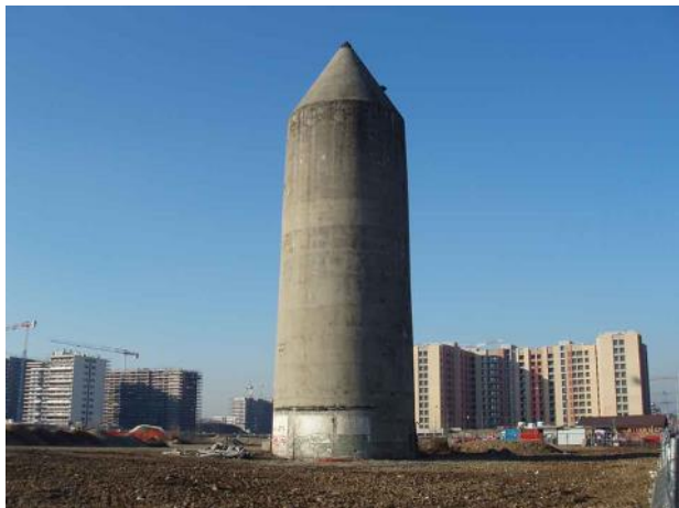
Fig. 49 - Il "Matitone". Si tratta del rifugio antiaereo per gli operai della Magneti Marelli: le centinaia di persone che dovevano affluire all'interno avevano come unico accesso un vano non più grande di una normale porta d'appartamento, chiudibile con un portello debolmente blindato.
