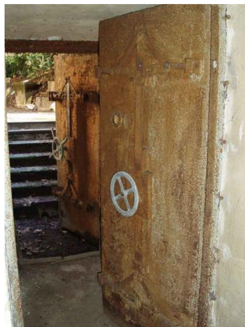
Fig. 7 - Bunker della Regia Prefettura e della Provincia: in primo piano abbiamo la porta denominata "antigas", munita di spioncino in vetro blindato, che chiude l'accesso al vano denominato "antiricovero". In secondo piano si vede la porta antiscoppio e la breve rampa di scale che conduce nel giardino di Palazzo Isimbardi, sede della Provincia di Milano.
