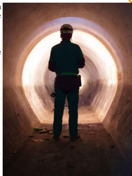
Fig. 46 - Bergamo: rifugio antiaereo di tipo tubolare in solo cemento, spesso circa 25 cm e interrato di non più di 30 cm, per gli operai della ditta Omba.
