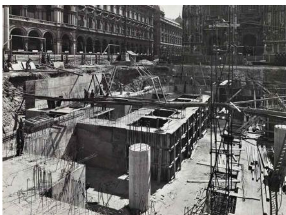
Fig. 4 - Milano, Piazza del Duomo, giugno 1943: il Comune di Milano sta facendo costruire il più grande rifugio antiaereo ad uso pubblico della città. Si tratta di una struttura in cemento armato, a prova di bomba e di aggressivo chimico; entrerà in funzione nel mese di agosto del 1944 (Cittadella degli Archivi e Archivio Civico Milano).
