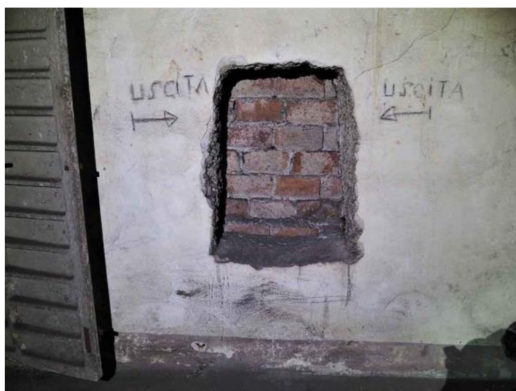
Fig. 38 - Ex fabbrica Livellara: "uscita" ricavata nel corso della guerra all'interno del rifugio antiaereo; a sinistra si noti la porta blindata della cella.
