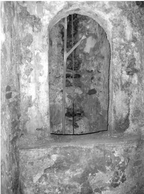
Fig. I.6. Inzago (Milano), edicola sotterranea d'accesso al pozzo (foto G.P., 2010).
