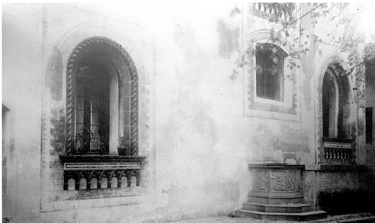
Fig. I.16. Milano: La Bicocca degli Arcimboldi e il suo pozzo ai primi del Novecento (foto proveniente dall'album fotografico Milano antica e dintorni , Milano s.d.). Attorno all'edificio fortificato il 27 aprile 1522 il capitano di ventura Prospero Colonna è al comando delle truppe della Lega e batte sul campo della Bicocca le truppe del re di Francia comandate da Odet de Foix conte di Lautrec.
