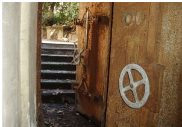
Figura 6. Le due porte di ingresso del Bunker; foto di G. Padovan.
