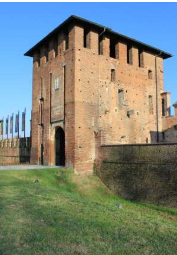
Fig. I.65. Lato nord-ovest del Castello di Legnano: la Porta-torre, costruita nella prima metà del XV sec., è l'unico accesso alla fortificazione (8 marzo 2019).
