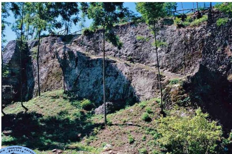
Fig. 53. Fossato dell'Opera a Corno e Controscarpa tagliati nella roccia. Come chiaramente mostra l'immagine la Controscarpa è dotata di rampa d'accesso, sempre tagliata nella matrice rocciosa, e di due grandi ambienti denominati Ricovero Maggiore e Ricovero Minore. Non mi risulta che le tavole d'epoca riportino tale dettaglio costruttivo e basarsi solo sulla documentazione d'epoca per la comprensione delle opere del passato è un grave errore.
