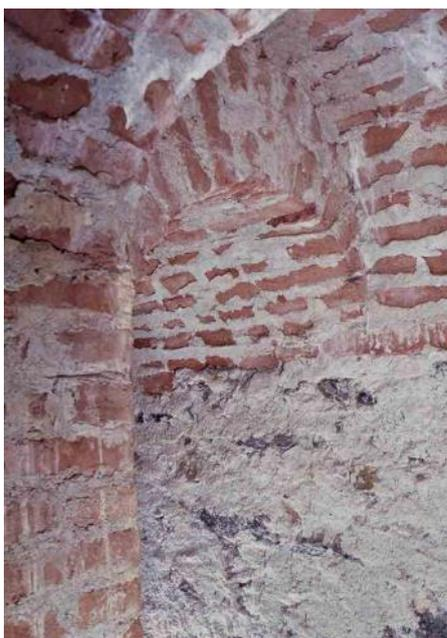
Fig. 34 - Ramo destro di contromina, anch'esso perfettamente integro.
