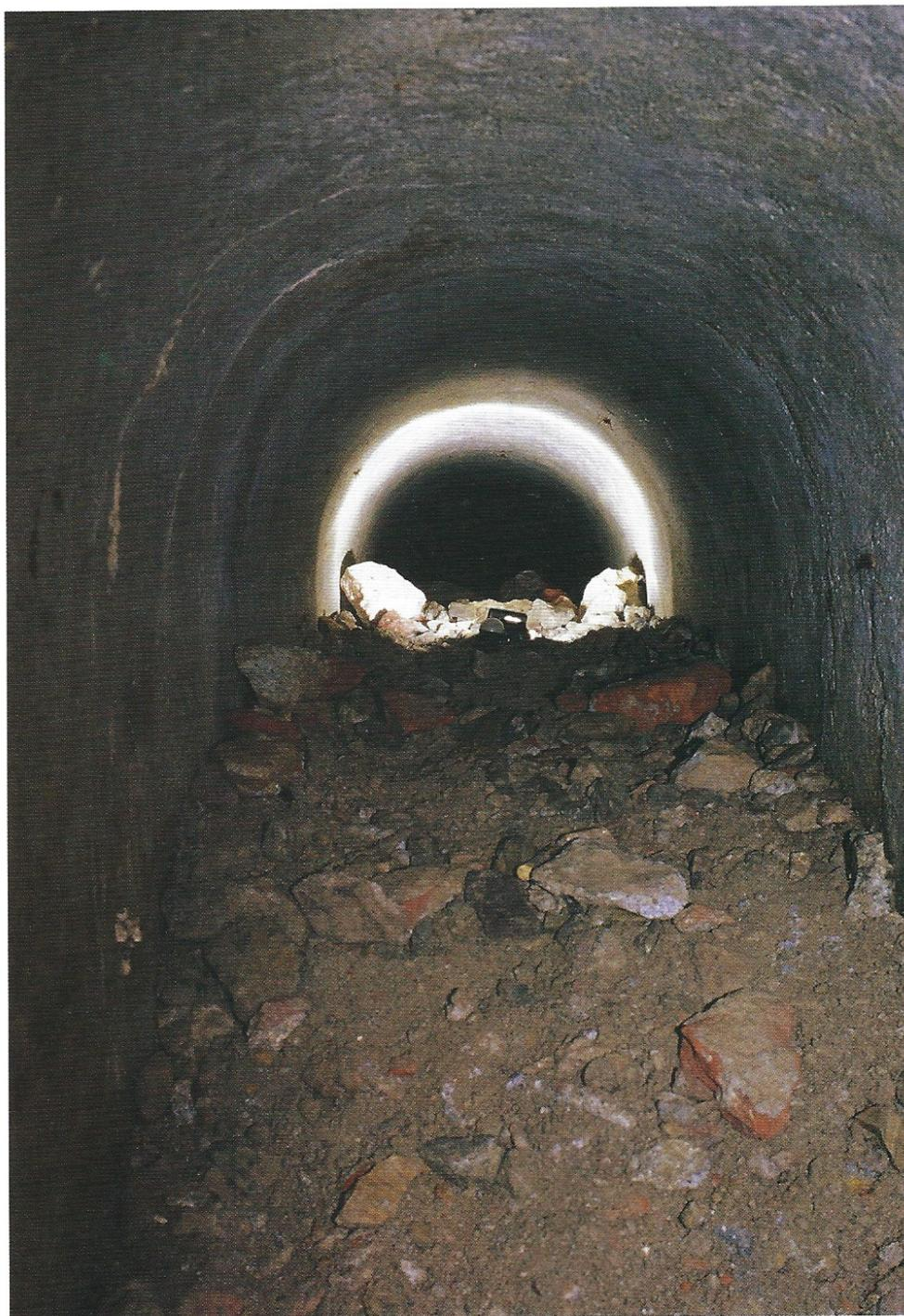
*Foto 7 - Il primo tratto del Galleria di Contromina della Controscarpa del Bastione di Sant'Ignazio (CA 00002 PI CN) è stato intenzionalmente riempito di macerie.*
