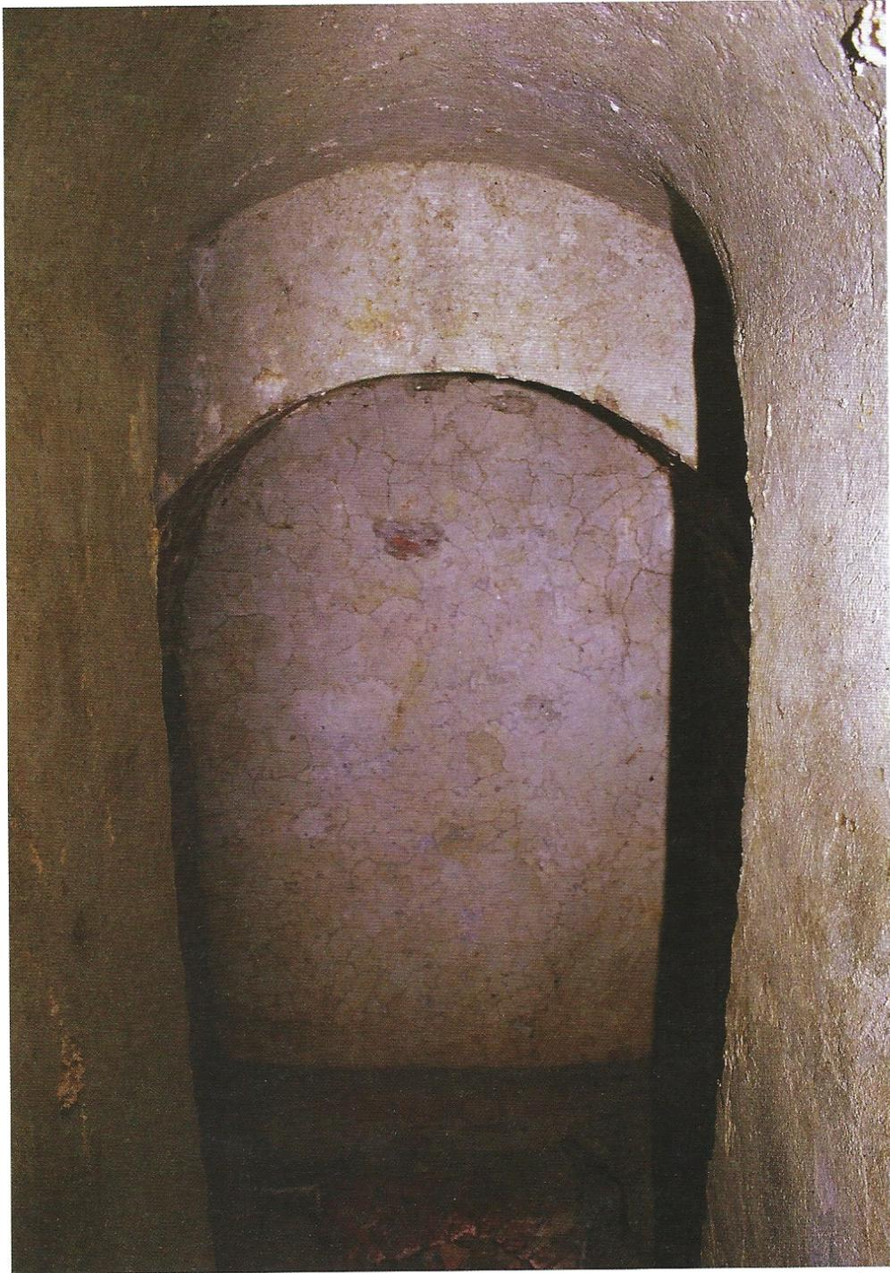
Foto 8 - Galleria di Contromina della Controscarpa del Bastione di Sant'Ignazio: al termine della galleria a sinistra e a destra si staccano i rami che conducono ai fornelli di mina, caricabili con "globi di compressione".
