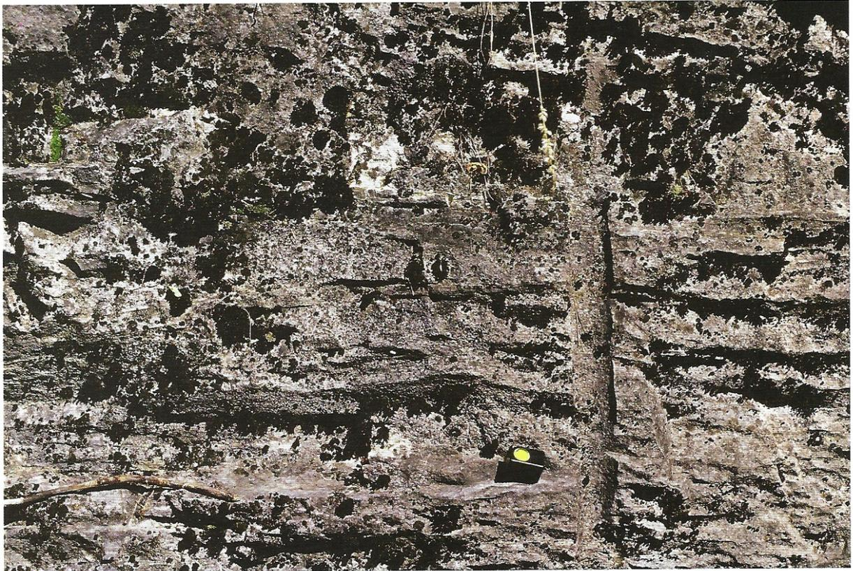
Foto 2 - Segno di fioretto lasciato sulla roccia calcarea nell'opera scoperchiata ricavata nella controscarpa del Fossato che protegge il Tenaglione verso Stura.
