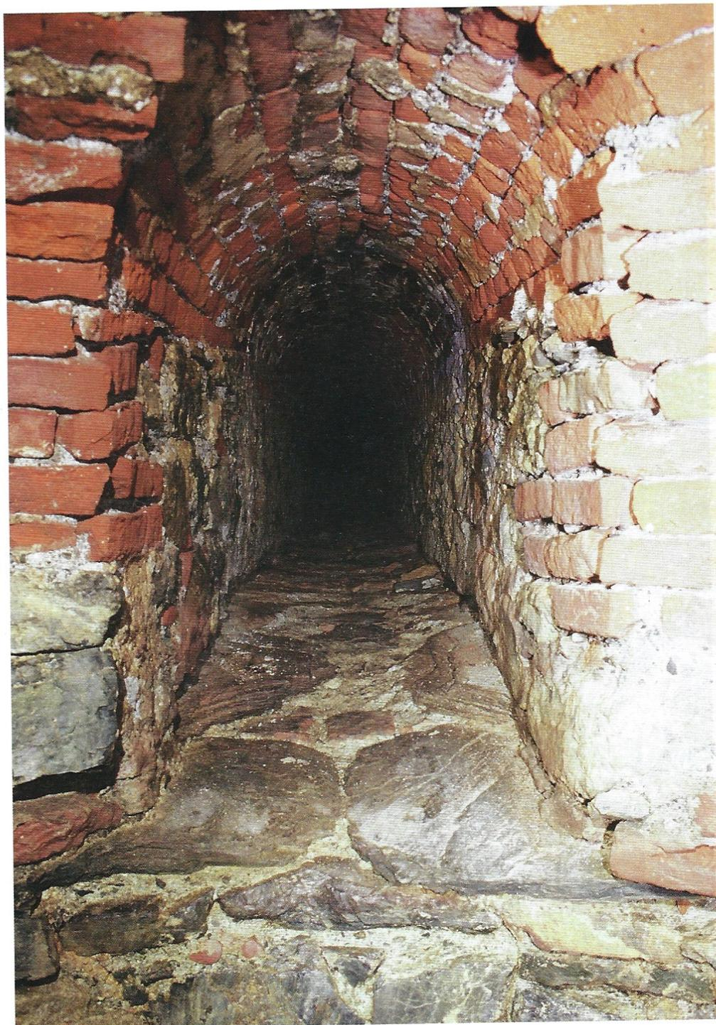
*Foto 11 - Cunicolo di Deflusso del Fossato del Bastione di Sant'Ignazio (CA 00003 PI CN): ultimo tratto che s'immette nella camera a pianta circolare.*
