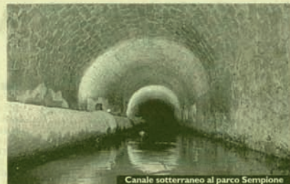
Canale sotterraneo al parco Sempione
